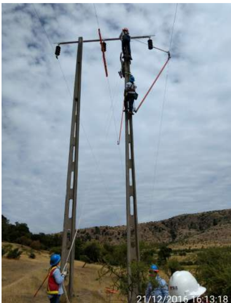
Fotografía N°2 – Faenas de remplazo del aislador en estructura N°70 del tramo de línea Los Maquis – Hualañe el día 21-12-2016.
