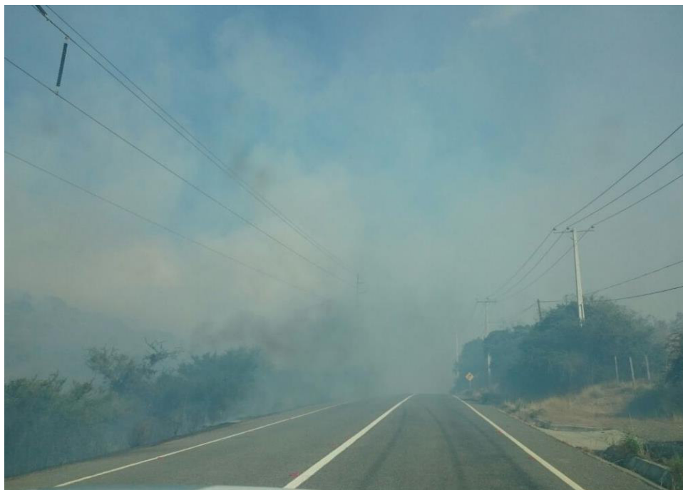
Foto 1: Incendio LT110 kV Quelentaro – Portezuelo.
