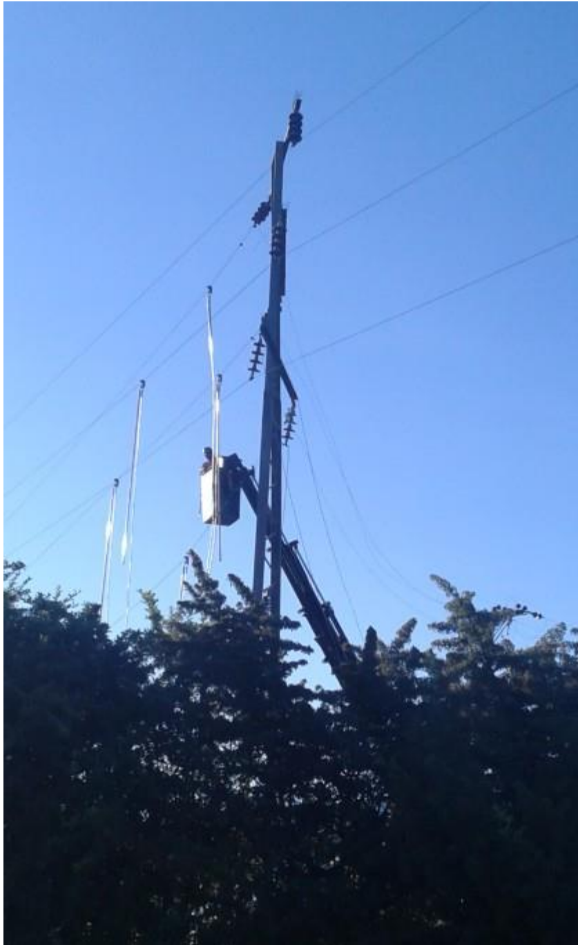
Fotografía N° 3: Actividad de configuración de zona de trabajo.
