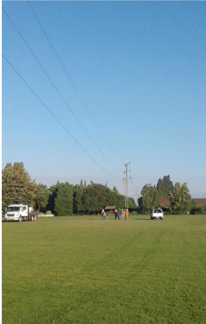
Fotografía N° 5: Faenas de reparación de conductores cortados de MT.
