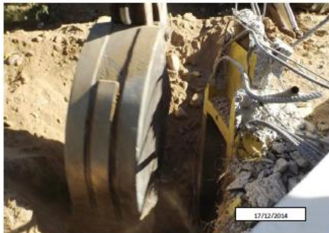
Retiro de postes dañados
