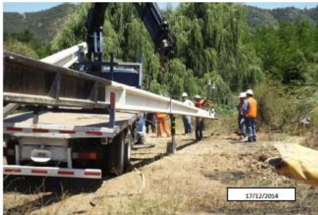
Trabajos de carga y traslado de postes de 16,5, desde SS/EE Alhue a lugar de siniestro
