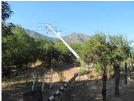
FOTO NRO. 11. - Panorámica estructura dañada N° 185. -
