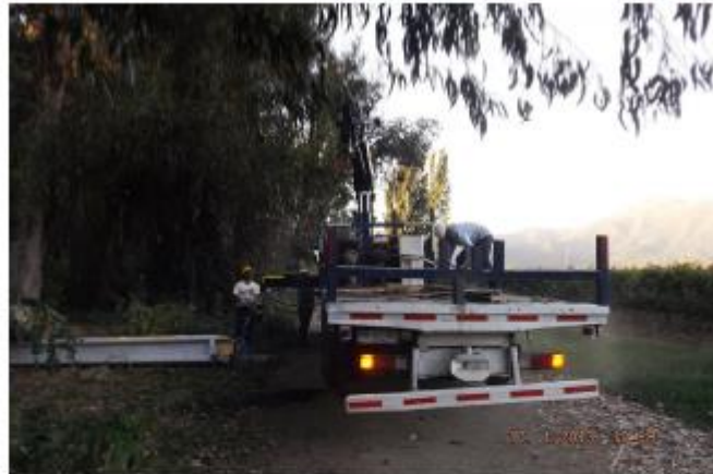
Descarga de poste dañados en Fundo Santa Rita
