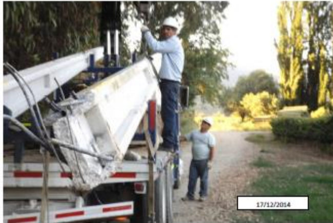
Retiro postes dañados
