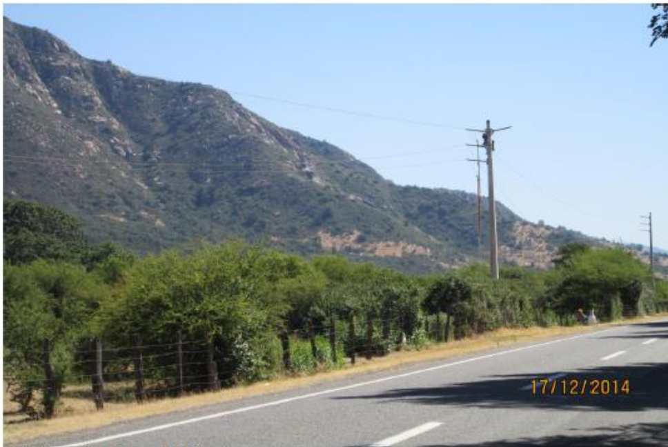
Imágenes de trabajos en E-184
