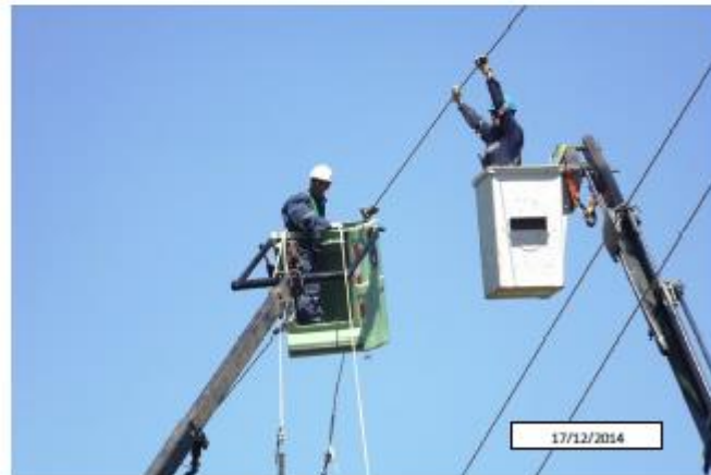
Trabajos de Instalación de poste y armado de estructura 186 y templado de línea
