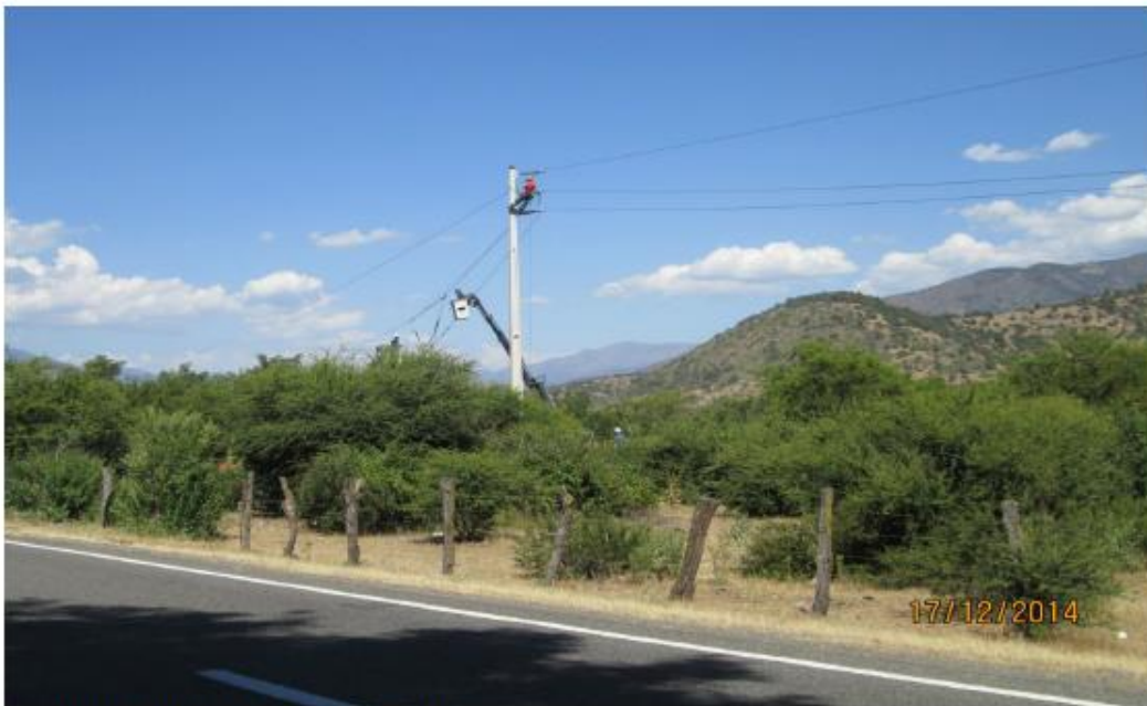
Imágenes Muestran los Trabajos en E-185
