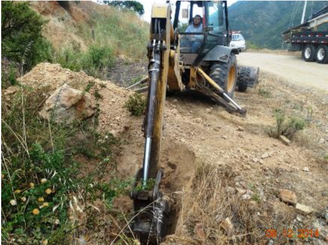
Foto 8: Trabajos de holladura para montaje de nueva estructura.
