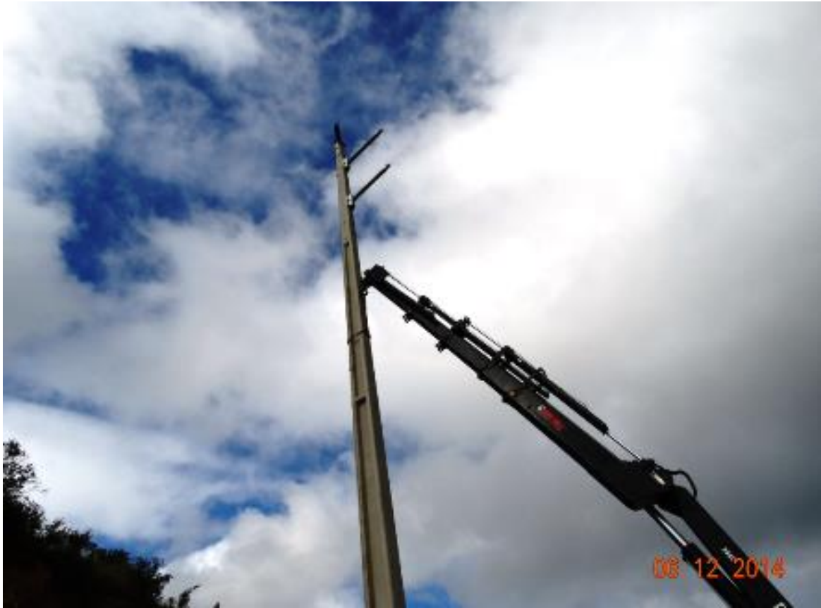
Foto 10: Montaje de nuevo poste de HA, de 16,5 mts.
