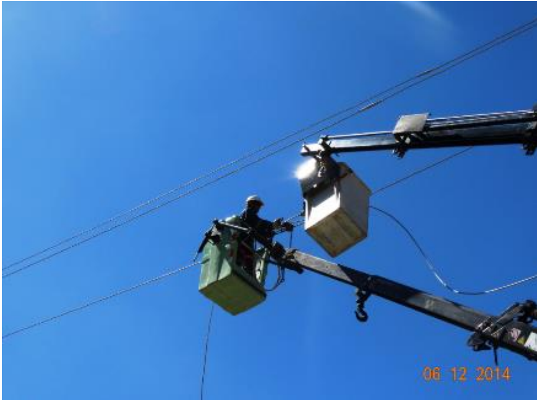
Foto 12: Tendido de conductor en nueva estructura N° 118
