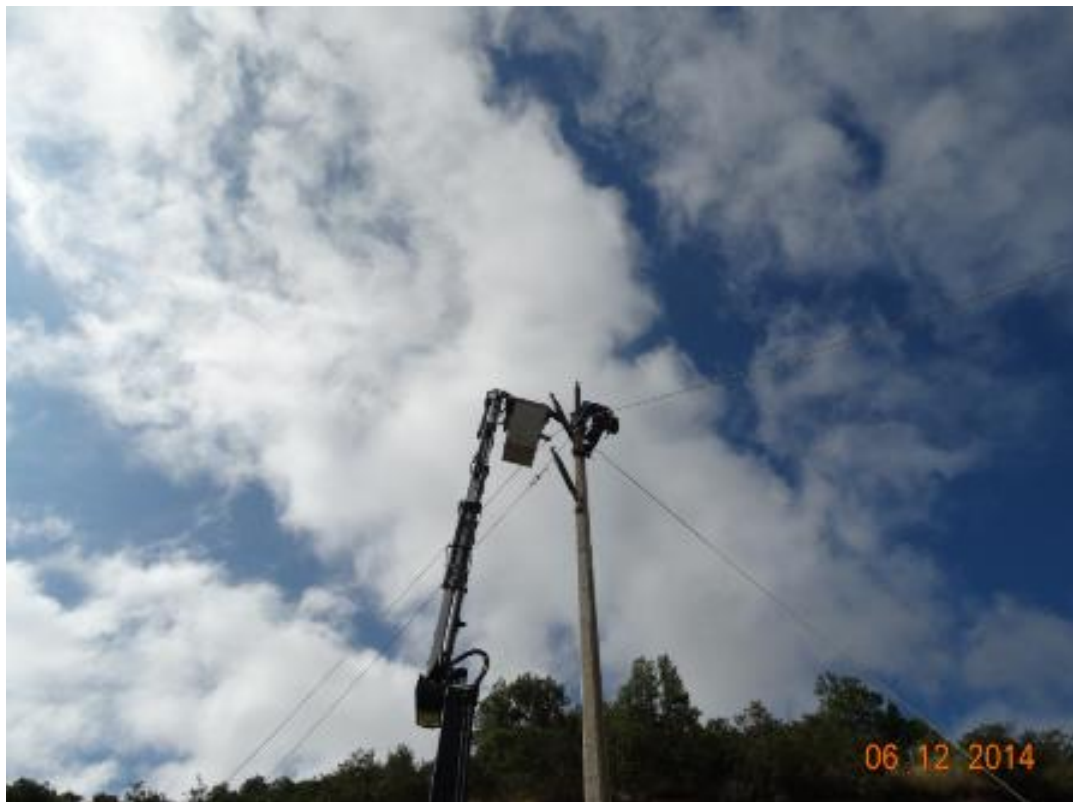
Foto 11: Trabajos de tendido de conductores.
