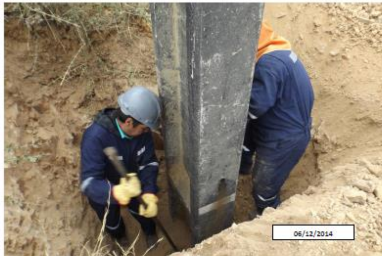
Trabajos de instalación de estructura
