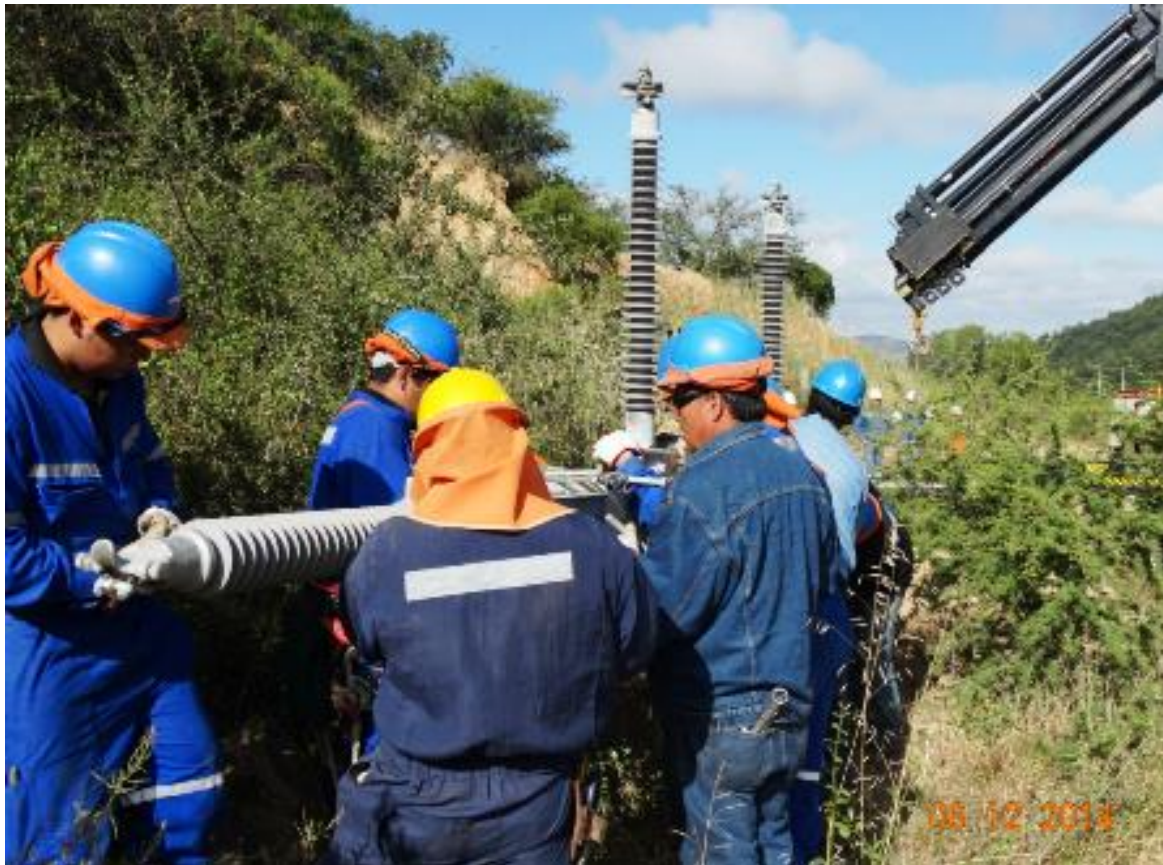
Foto 9: Trabajos de montaje de aisladores en nueva estructura.
