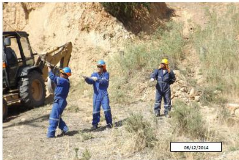
Trabajos de templado de línea y finalización de labores
