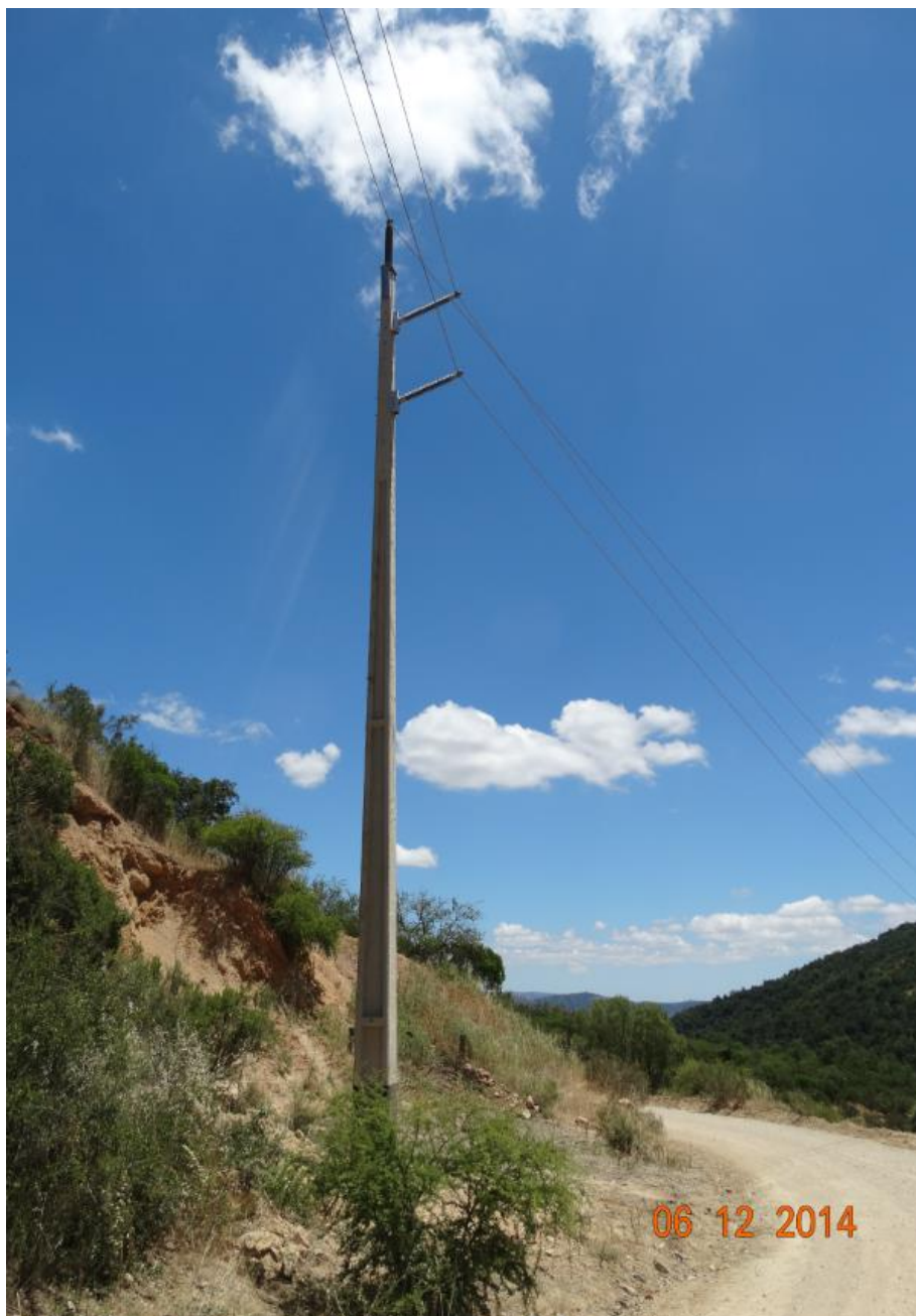
Foto 13: Vista final de la nueva estructura N° 118.
