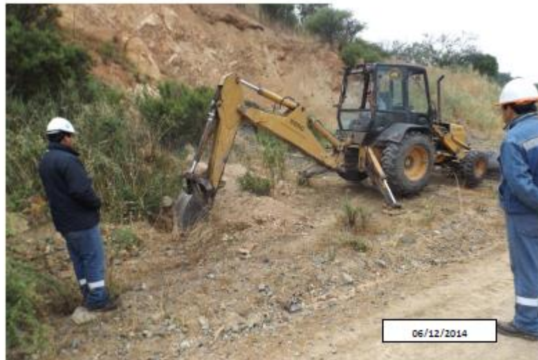
Trabajos de excavación para instalación de poste
