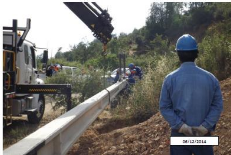
Procedimiento de instalación de poste
