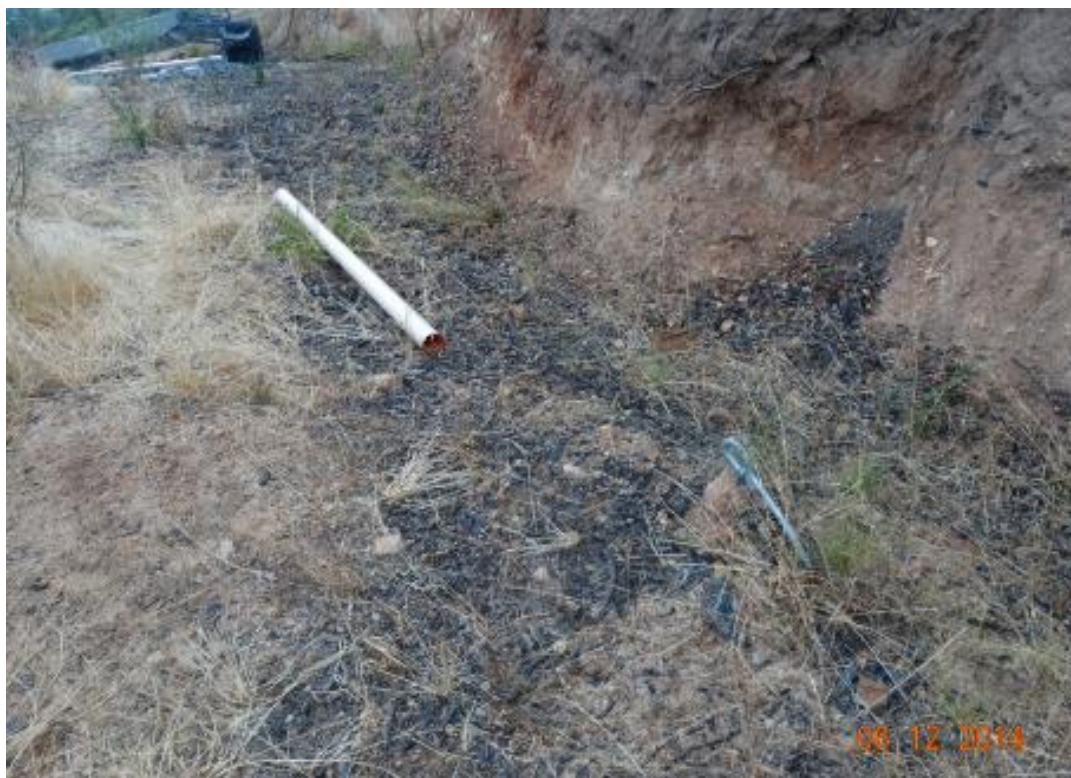
Foto 4: Tirantes cortados por terceros durante acto vandálico, en estructura N° 118. Para poder derribar las estructuras del portal de anclaje, se cortaron los tirantes que estabilizaban mecánicamente la estructura, esto en conjunto con el debilitamiento al destruir el hormigón armado, en la base, y el corte de su enfierradura.
