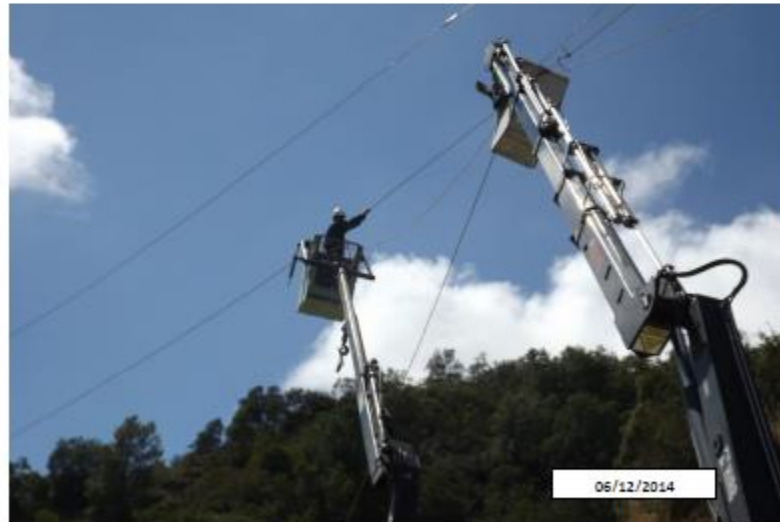
Trabajos de instalación y construcción de estructura
