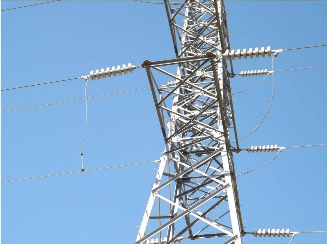
Foto N°2 Muestra apertura de puentes E243 LT 110 kV Pan de Azúcar – Peñón.
