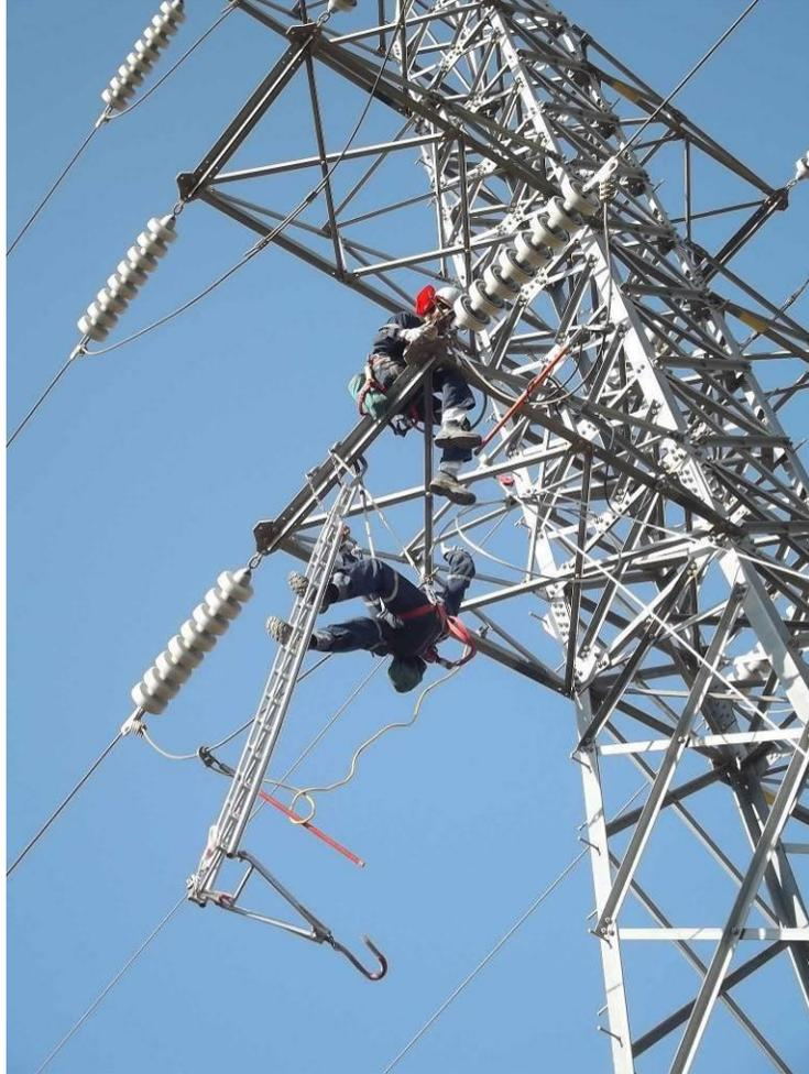
Foto N°3 Muestra reparación de puentes E243 LT 110 kV Pan de Azúcar – Peñón.
