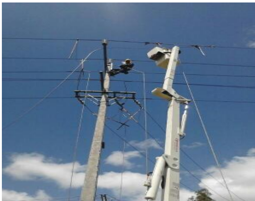
Figura 4. Fotografía que muestra reparación del vano en la estructura 192.
