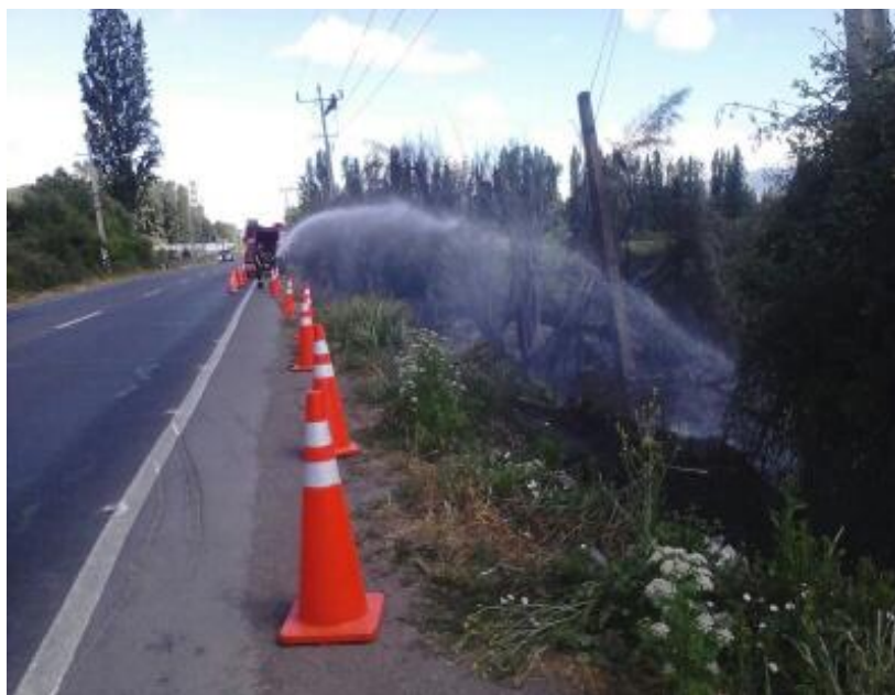
Figura 3. Fotografía que muestra reparación del vano y extinción del incendio.
