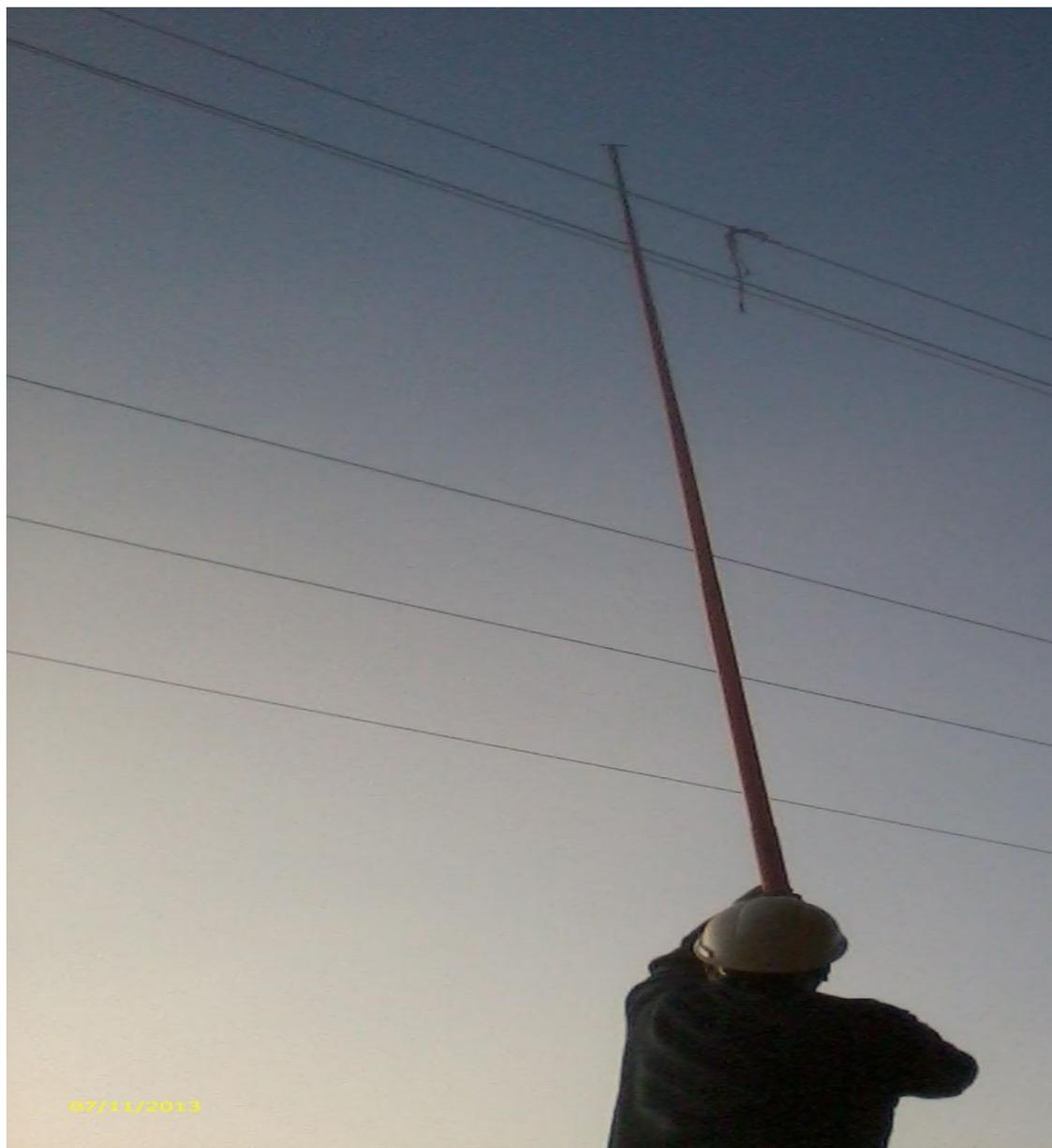
Foto 2: Retiro con pértiga aislada de Corteza de eucaliptus.
