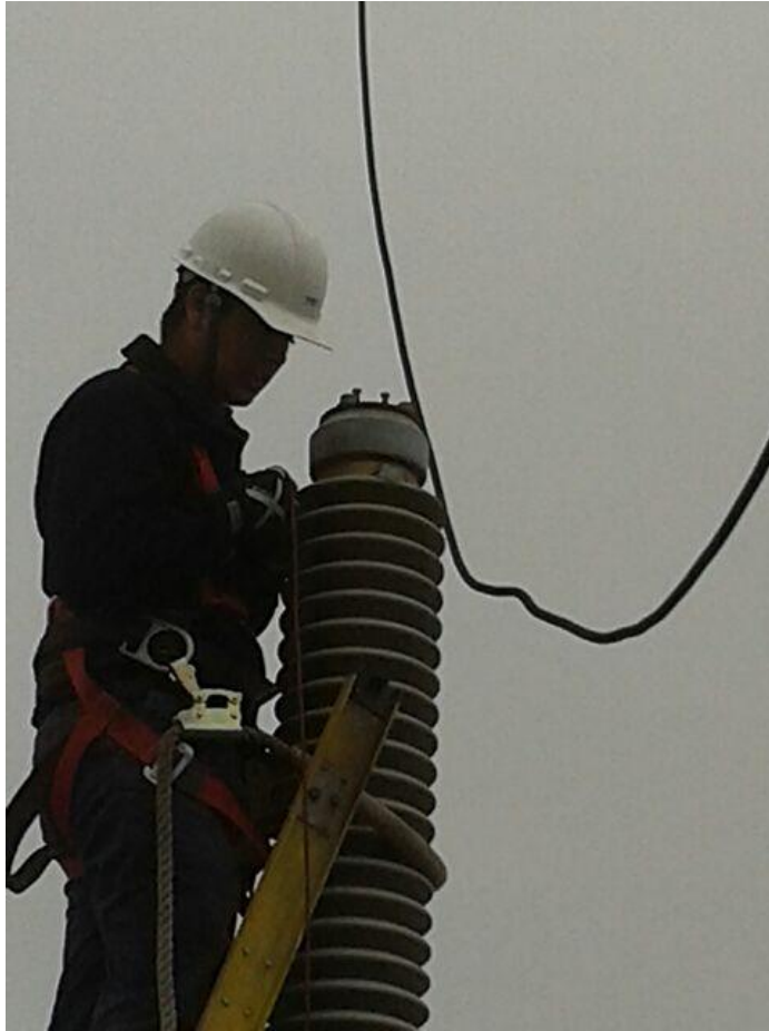
Fotografía N°1: Trabajos atención a la falla.
