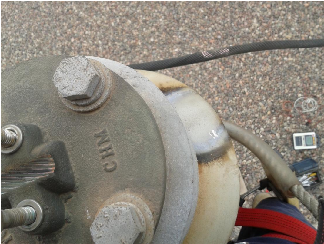
Fotografía N°2 aislador de pedestal asociado a 89HT1.
