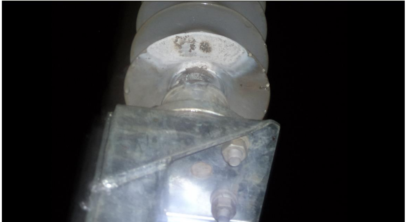
Fotografía N°2.- Descarga en Line post Central producido por la corteza de eucalipto en estructura N°197
