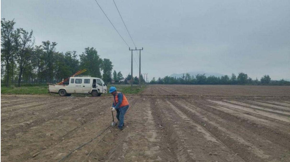
Imagen c) Labores de reparación de conductor cortado
