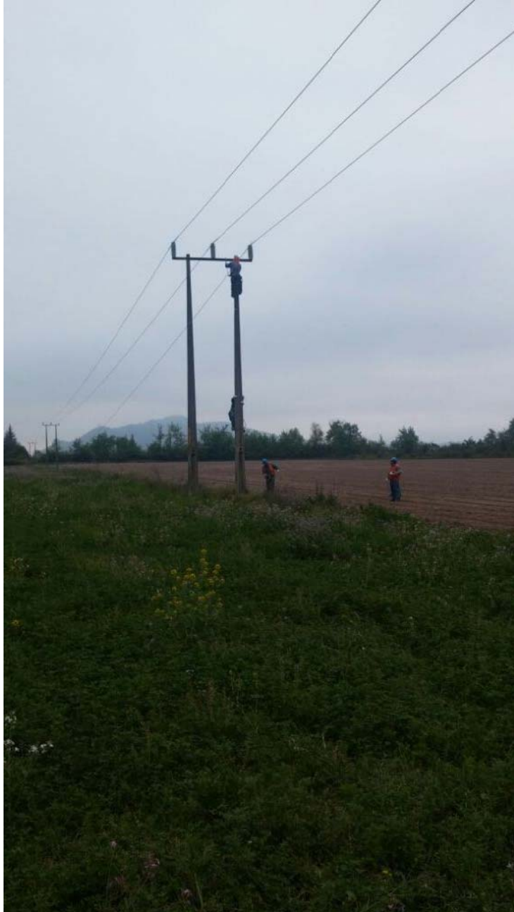
Imagen e) Termino de trabajos de reparación
