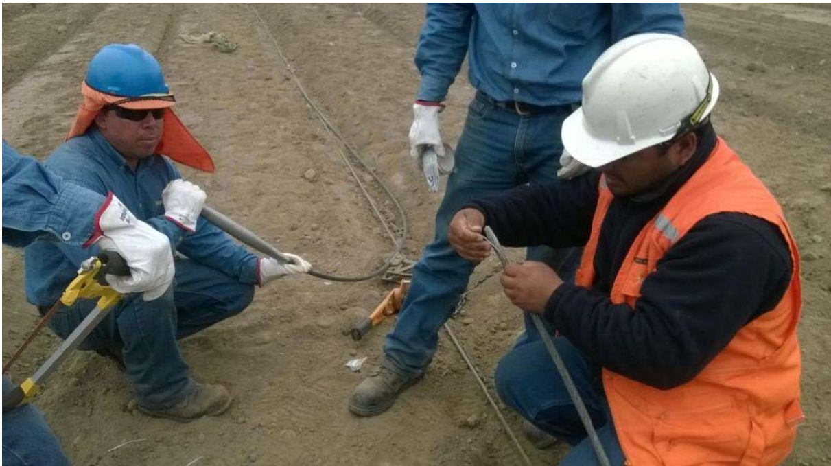
Imagen d) Labores de reparación de conductor cortado
