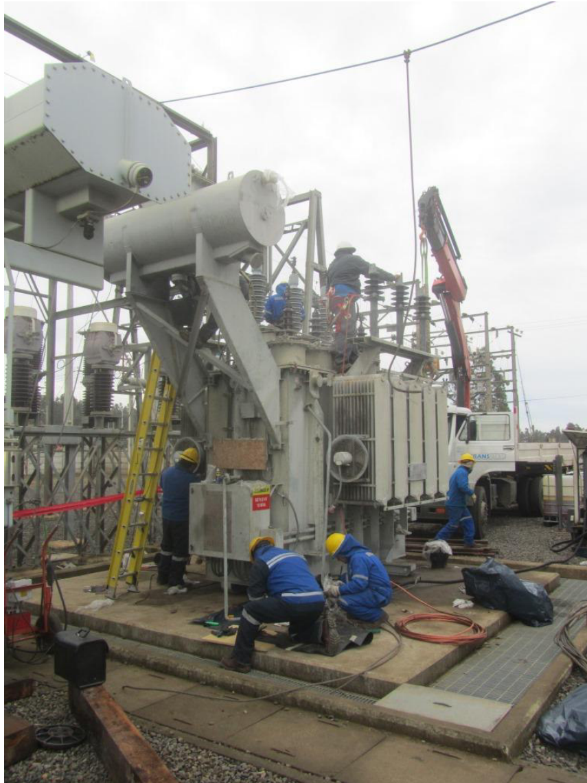
Faena de reemplazo de transformador N°1
