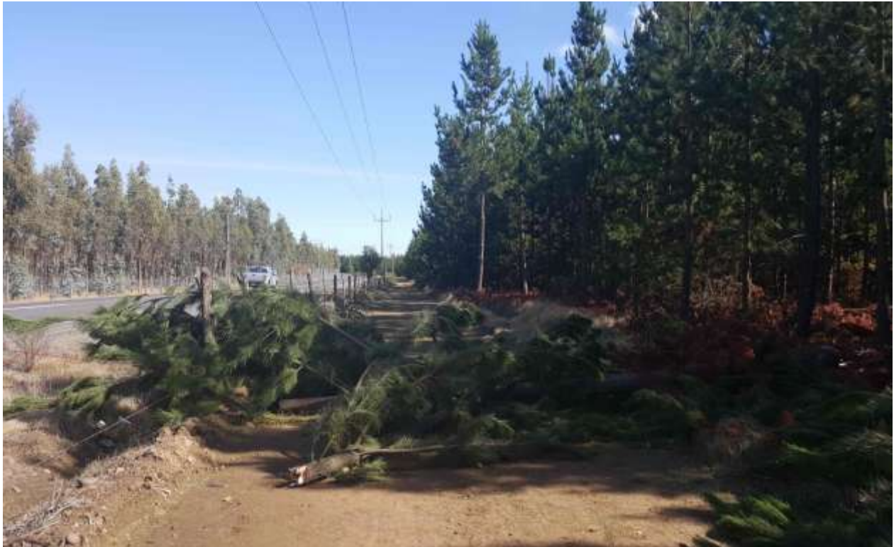
Fotografía N°1. Árbol retirado de la LT, sin provocar daños a la instalación
