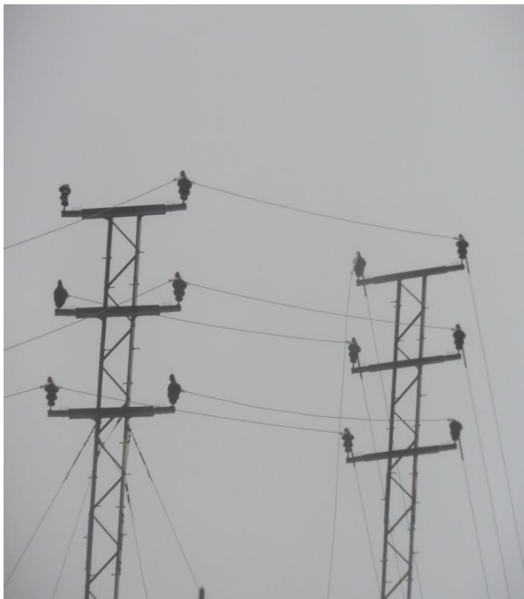
Fotos: Estructuras con conductores cortados y aisladores reventados
