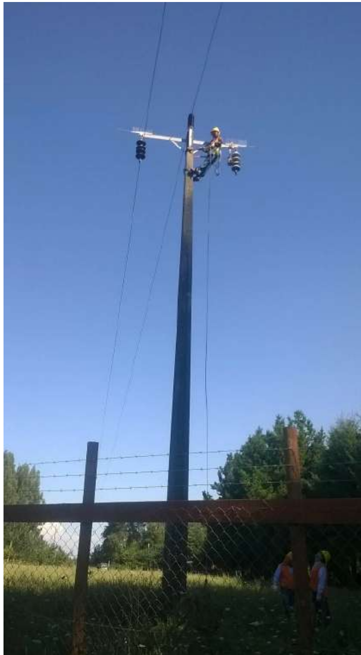
Fotografía 3. Faenas de reparación entre estructuras 311-312
