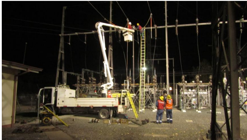
Registró de los trabajo de desmontaje y retiro de los pararrayos de la barra N°2 día 20.04.2014
