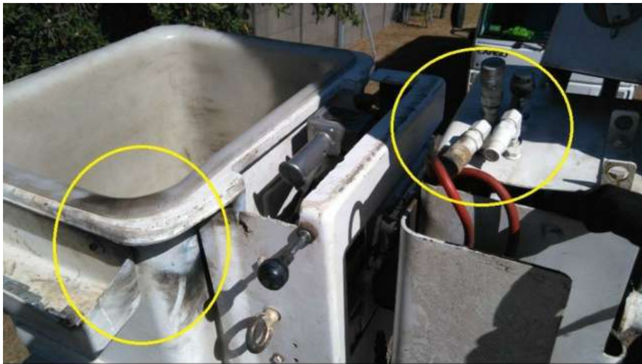
Fotografía N°1: Capacho de camión brigada LLVV que hizo contacto accidental con conductores
