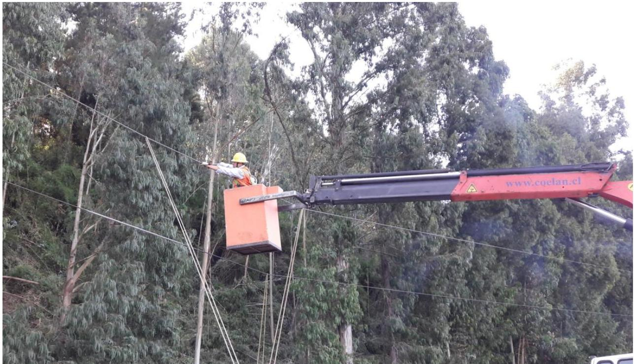
**Fotografía N°3.** Reparación línea con hebras cortadas.
