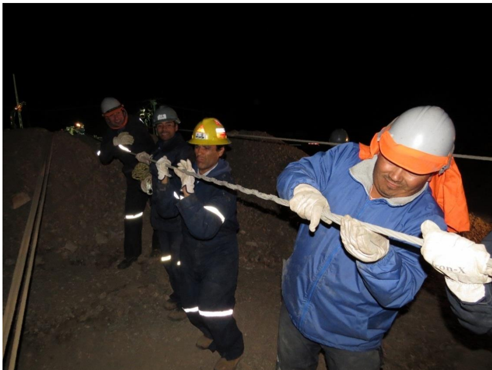
Fotografía N° 14. Trabajos de instalación preformadas de reparación vano Estructuras N°42 y N°43
