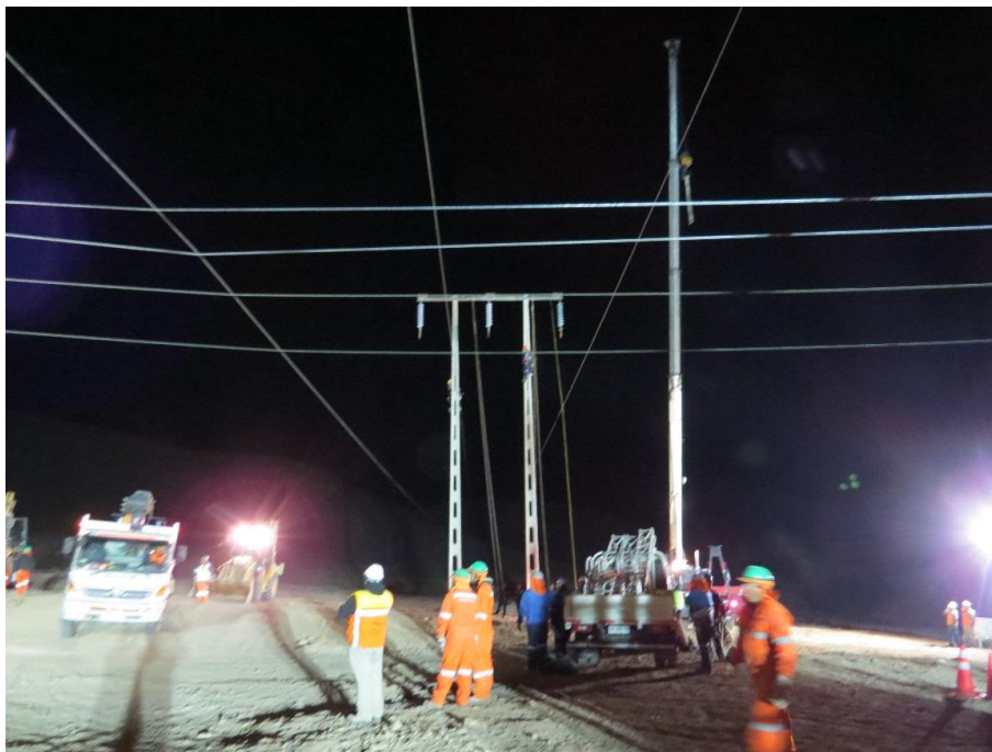
Fotografía N° 15. Trabajos de normalización Estructura N°43
