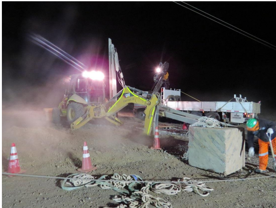
Fotografía N° 12. Trabajos de normalización Estructura N°43
