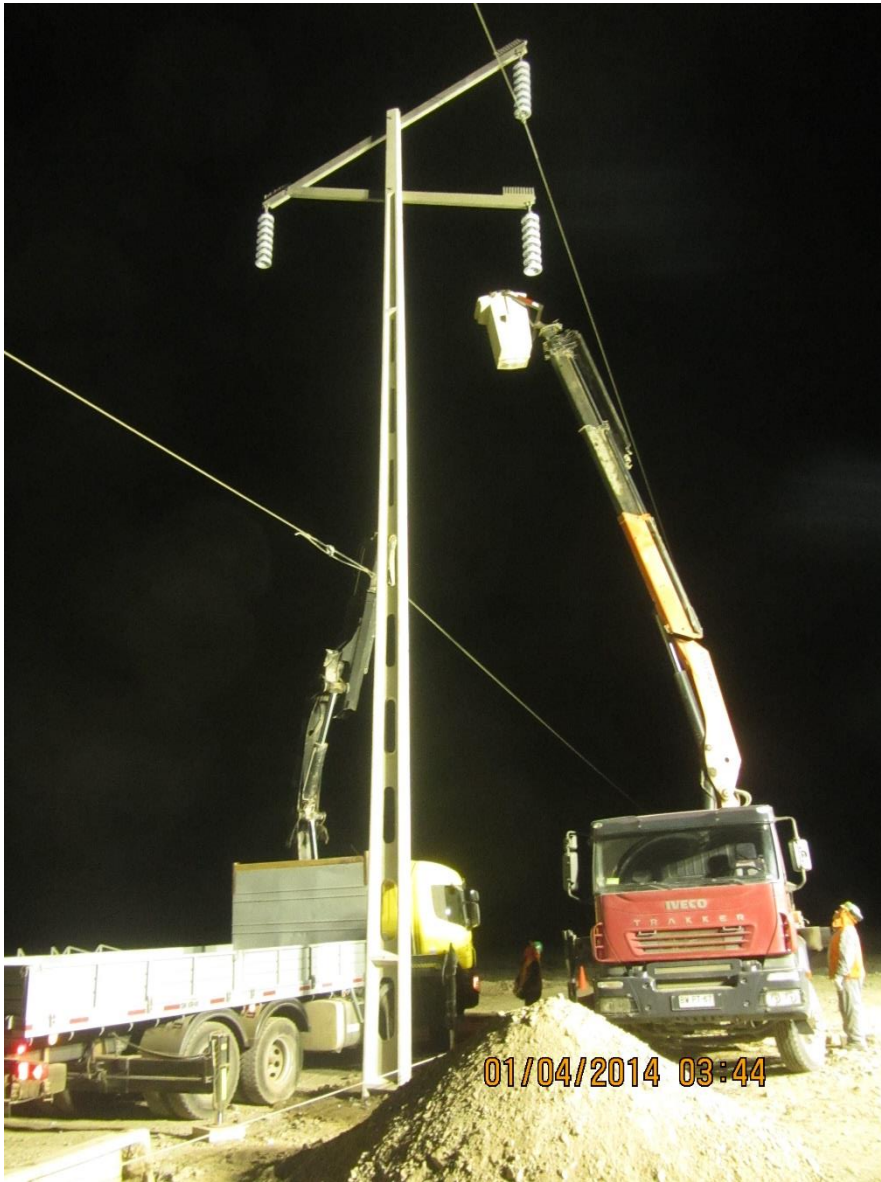
Fotografía N° 16. Trabajos de normalización Estructura N°44
