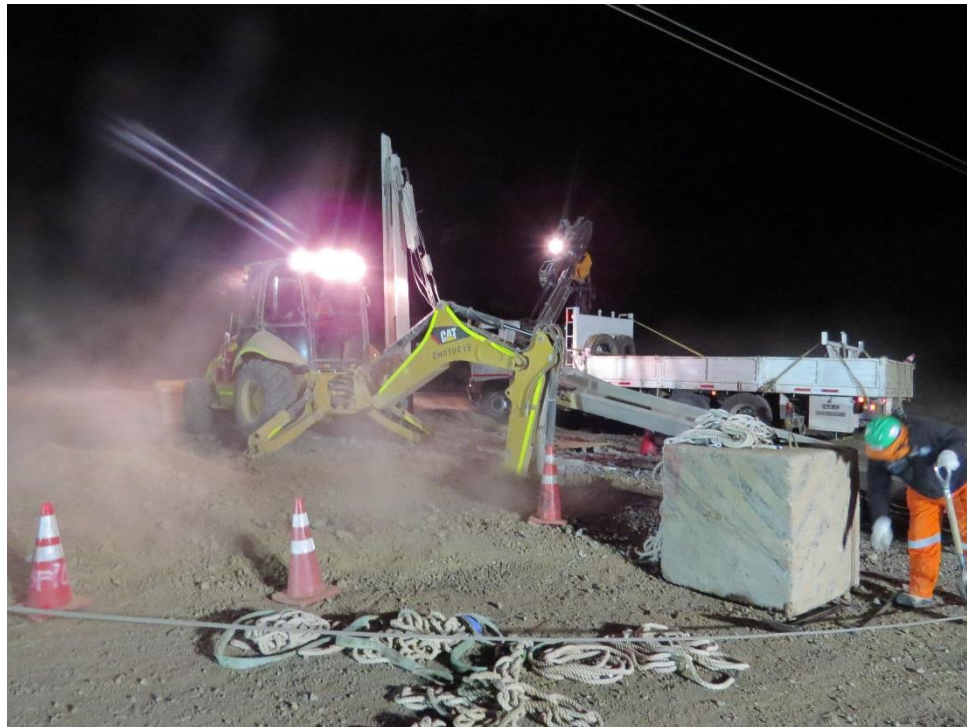
Fotografía N° 12. Trabajos de normalización Estructura N°43
