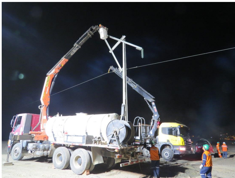
Fotografía N° 13. Trabajos de normalización Estructura N°42
