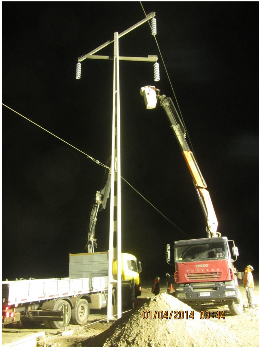
Fotografía N° 16. Trabajos de normalización Estructura N°44
