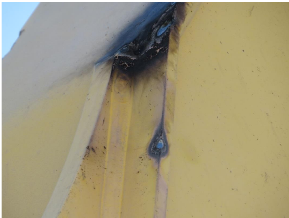
Fotografía N° 9. Evidencia de descarga en máquina retroexcavadora causante de los daños a la línea
