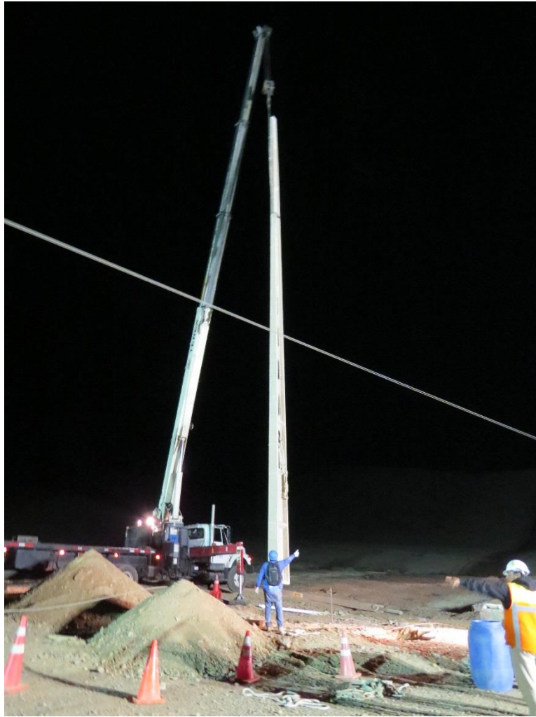
Fotografía N° 14. Trabajos de normalización Estructura N°43
