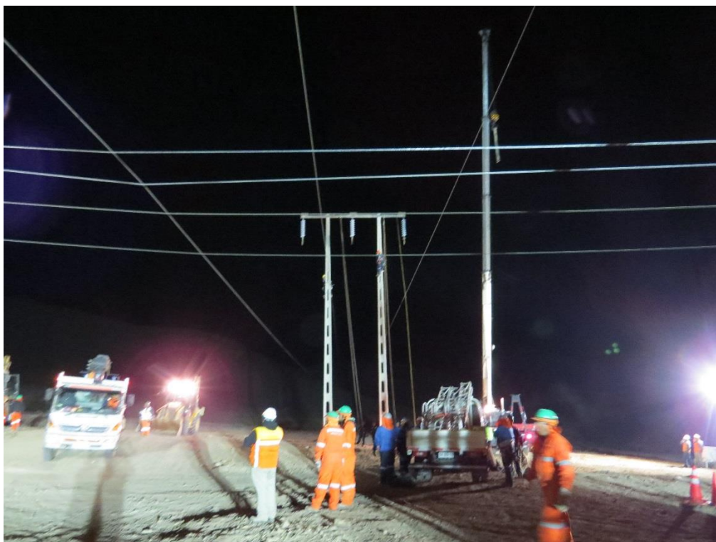
Fotografía N° 15. Trabajos de normalización Estructura N°43
