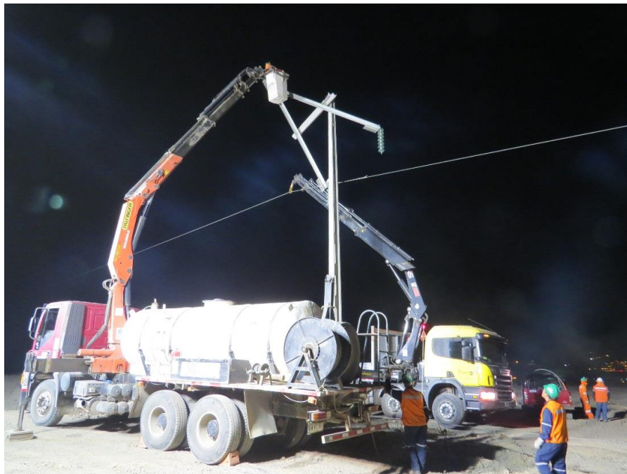
Fotografía N° 13. Trabajos de normalización Estructura N°42
