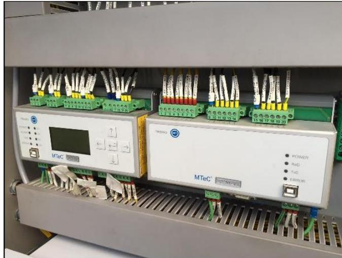
Fig. N°1: Equipo EPT202 instalado en el gabinete del transformador
