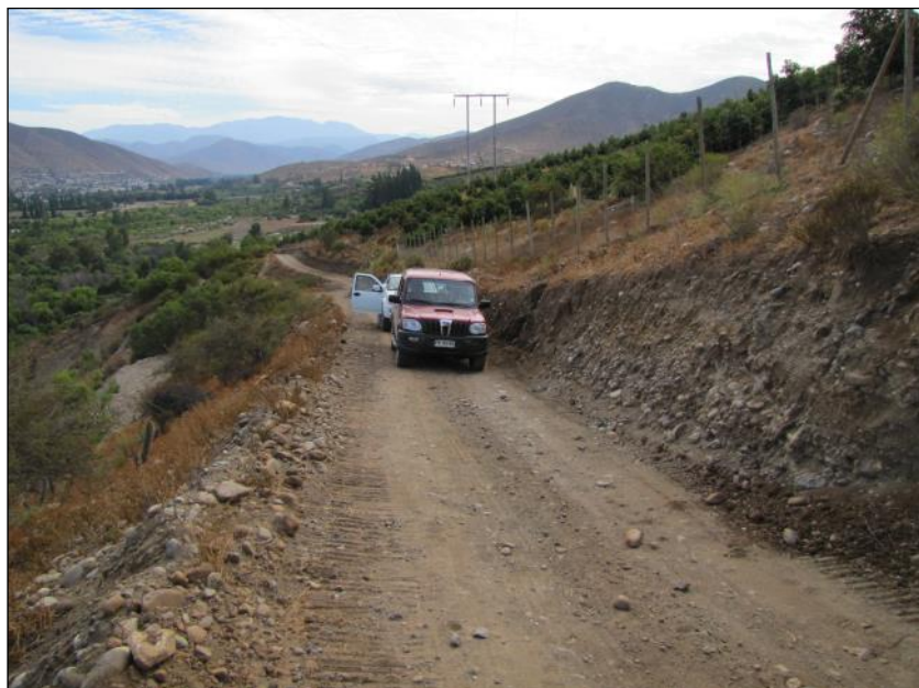
Imagen: Lugar de la falla y huellas de excavadora
