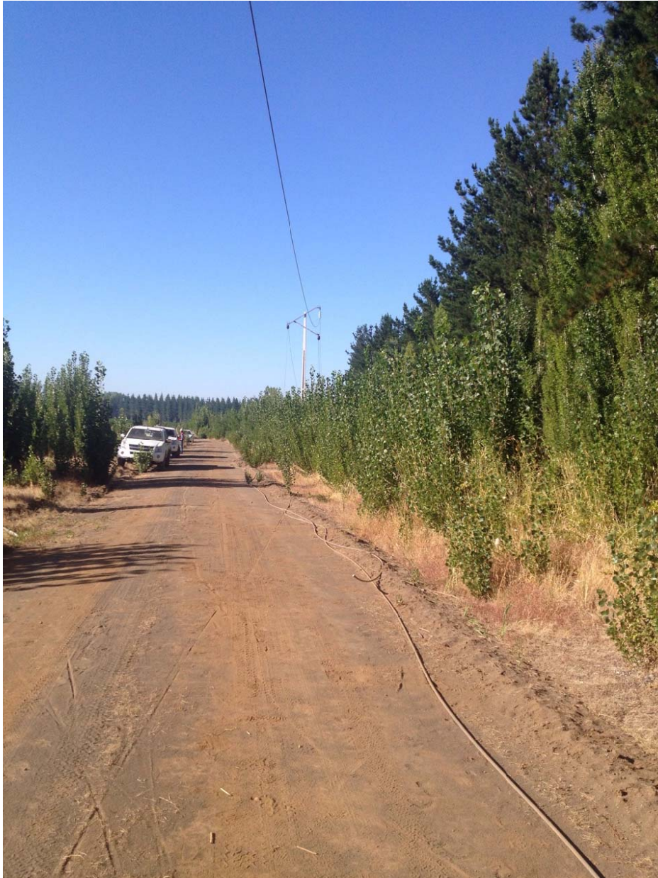
Fotografía N°1.- Se muestra la reparación del tramo de línea 66kV Charrúa – Tap Tres Esquinas.
