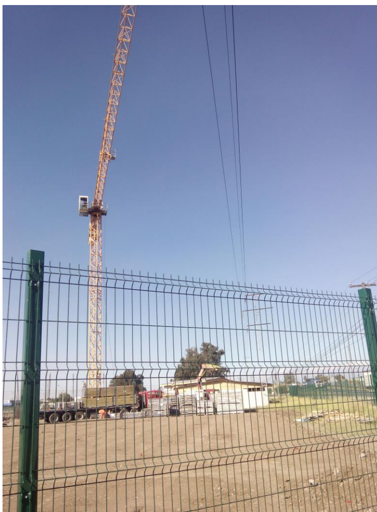
Fotografía N°1. Estructura N°267 de la LT 66kV Teno - Curicó.
