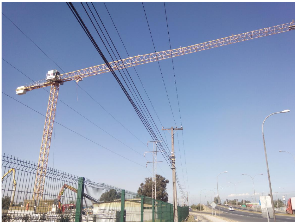
Fotografía N°2. Estructura N°267 de la LT 66kV Teno - Curicó.
