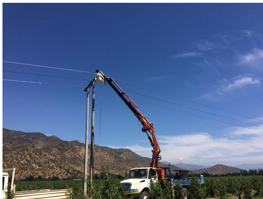
Imagen d) Fase final de trabajos de reparación
