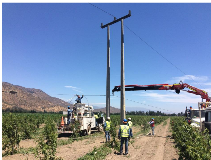
Imagen b) Labores de reparación de la línea
