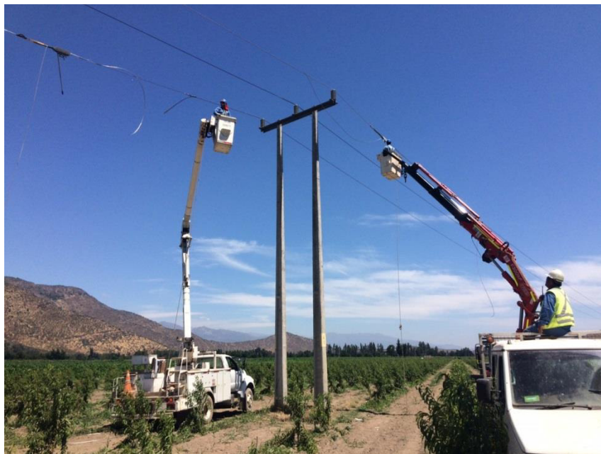
Imagen c) Labores de reparación de conductor cortado
