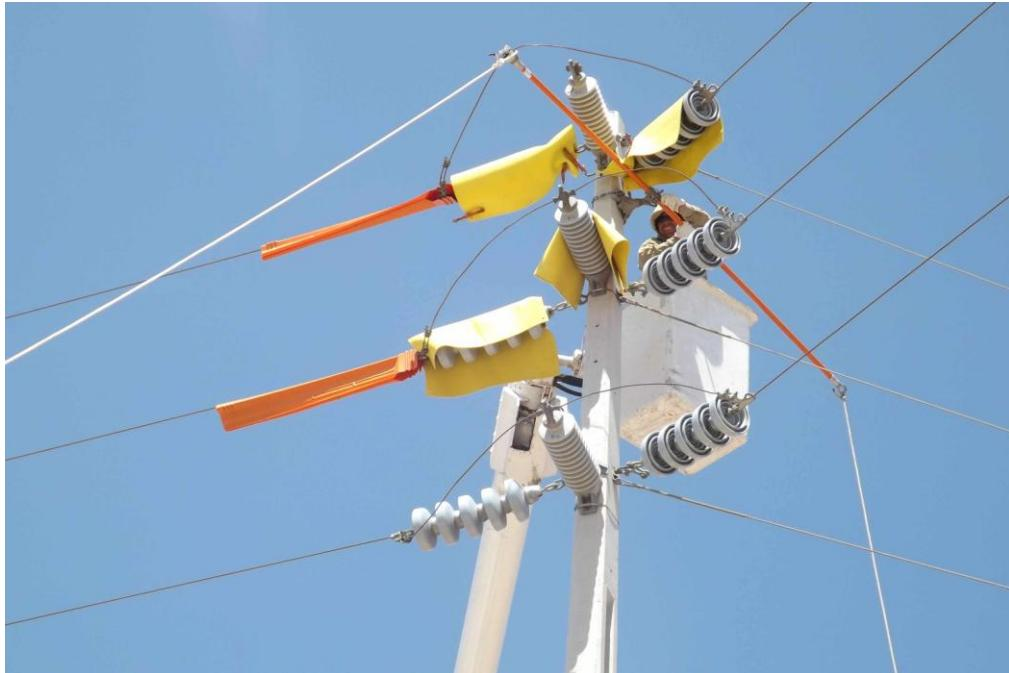
Foto muestra faena reemplazo aislación estructura N°9A.
