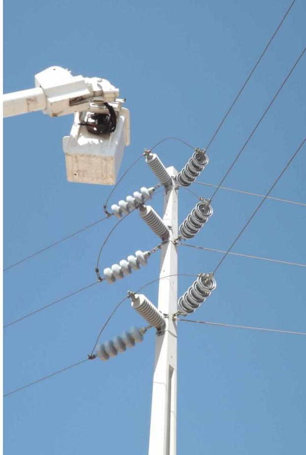
Estructura N °9A con linepost Reemplazado
