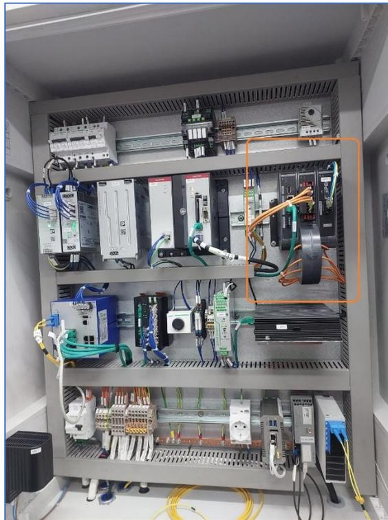
Fig. 6-2: Disposición del medidor de calidad de energía en el PPC.
