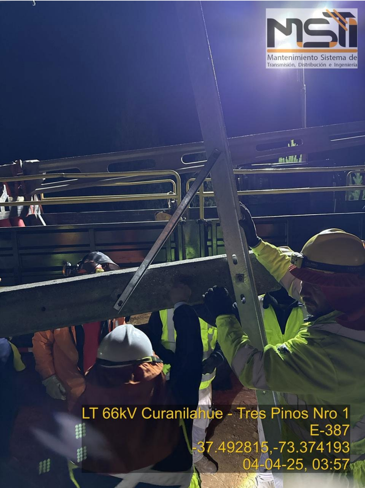
Fotografía Nº 3: Reparación línea LT 66 kV Curanilahue-Tres Pinos N° 1.
