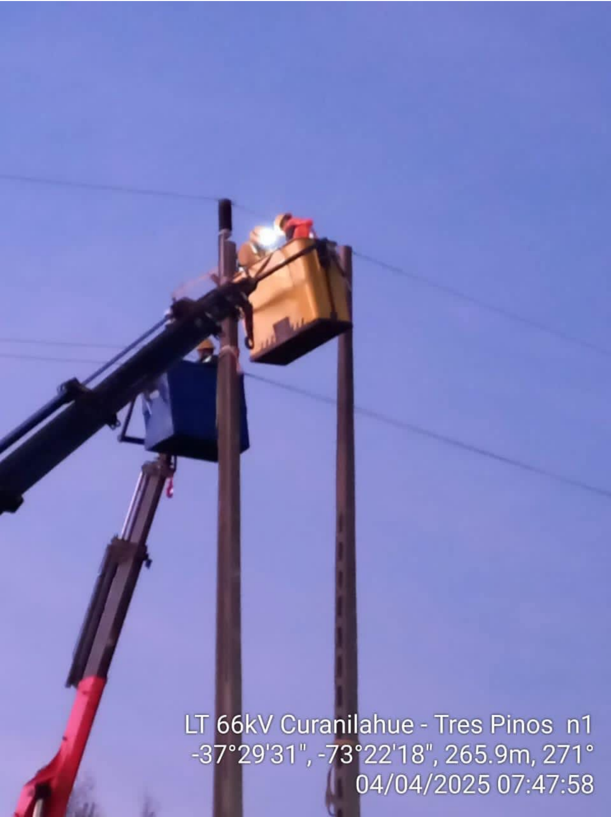
Fotografía Nº 4: Reparación línea LT 66 kV Curanilahue-Tres Pinos N° 1.
