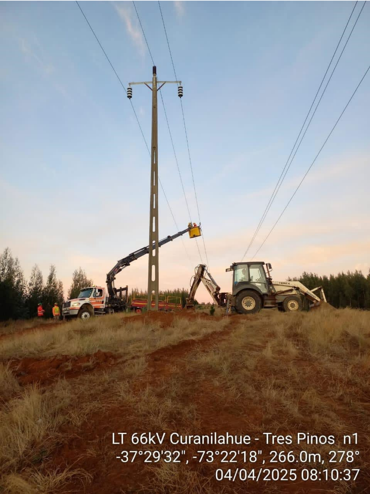
Fotografía Nº 5: Trabajos de normalización de estructuras y conductores en línea LT 66 kV Curanilahue-Tres Pinos N° 1.
