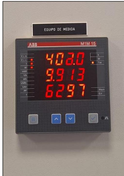
Figura 3.7 – Medidor de Consumo SSAA esenciales Parque Fotovoltaico Leyda
