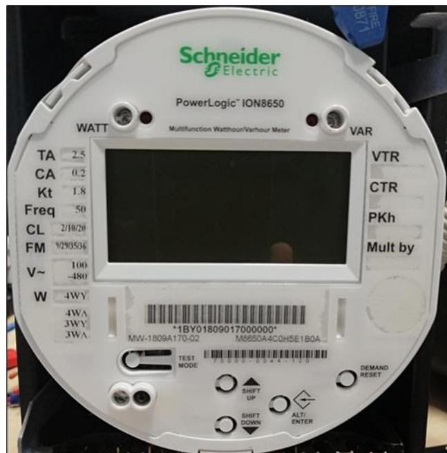
Figura 9-15 – Equipo medidor ION 8650 – Potencia bruta U2
