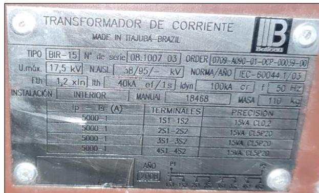
Figura 9-12 – Datos de placa de TTCC de generadores (Fases A-B-C)
