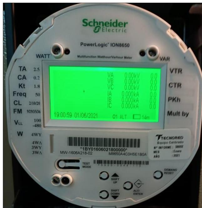
Figura 9-15 – Equipo medidor ION 8650 – Potencia bruta U2
