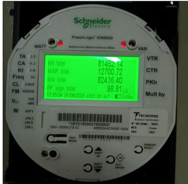
Figura 9-14 – Equipo medidor ION 8650 – Potencia bruta U1
