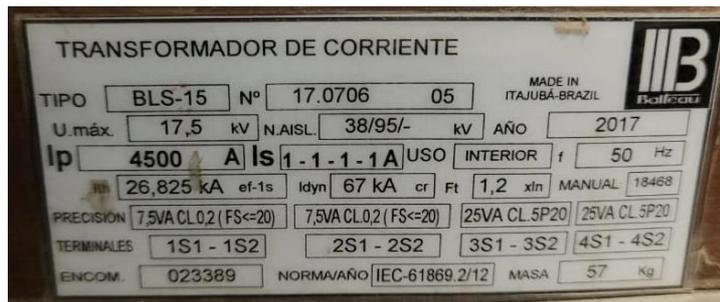
Figura 9.12 – Datos de placa de TC de generadores (Fases A-B-C)
