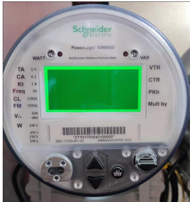
Figura 9-14 – Equipo medidor ION 8650 – Potencia bruta U1
