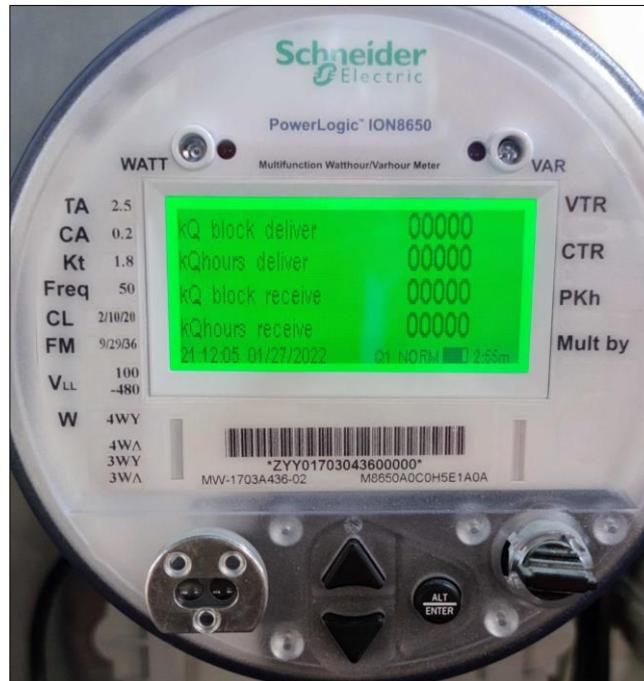
Figura 9.20 – Equipo medidor ION 8650 – Potencia neta U1
