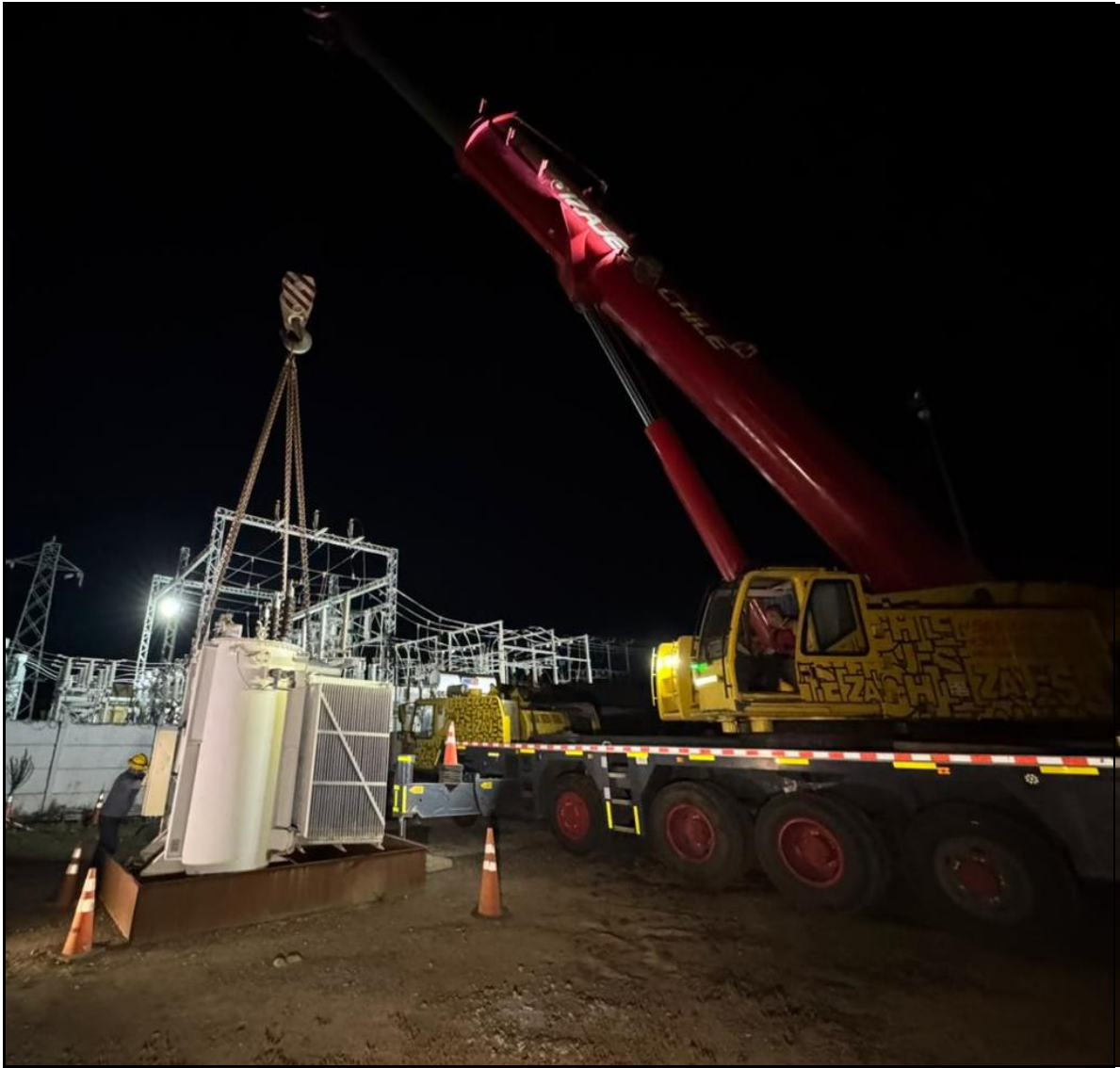
Figura 3: Traslado de transformador de reemplazo.
