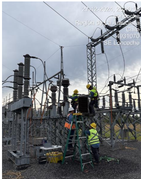
Fotografía 2. Trabajos de reemplazo de TTCC dañado en paño B7 de S/E Loncoche.
