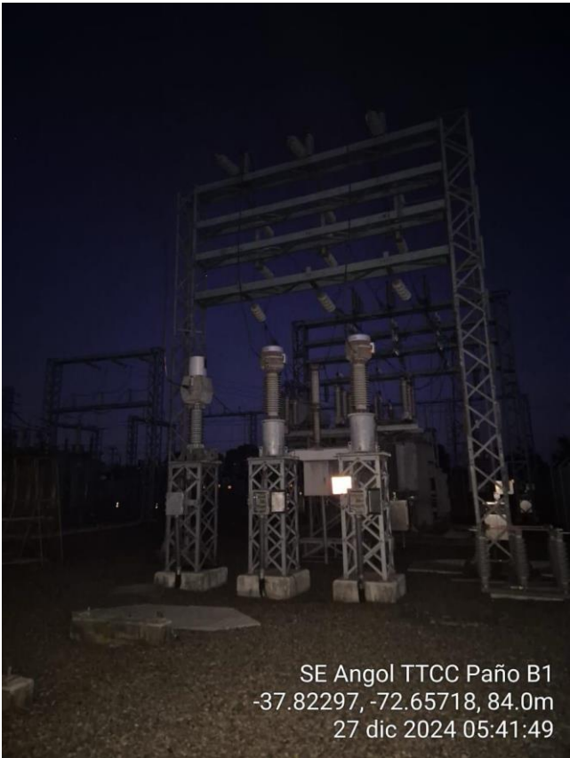
Fotografía N°3. Trabajos finalizados por reemplazo del transformador de corriente del paño B1 dañado en S/E Angol
