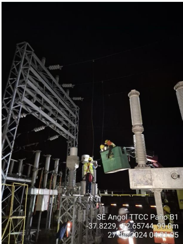
Fotografía N°2. Reemplazo del transformador de corriente del paño B1 dañado en S/E Angol
