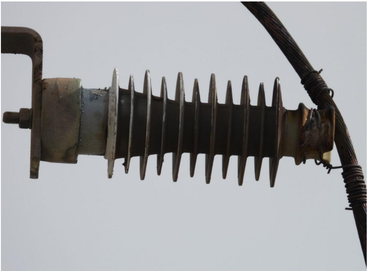
AISLACIÓN ESTRUCTURA SUPERIOR LADO FUENTE 52ET3 UBICADA EN INTERIOR SE LA PORTADA AFECTADA POR DESCARGAS PRODUCIDAS POR AVE .
