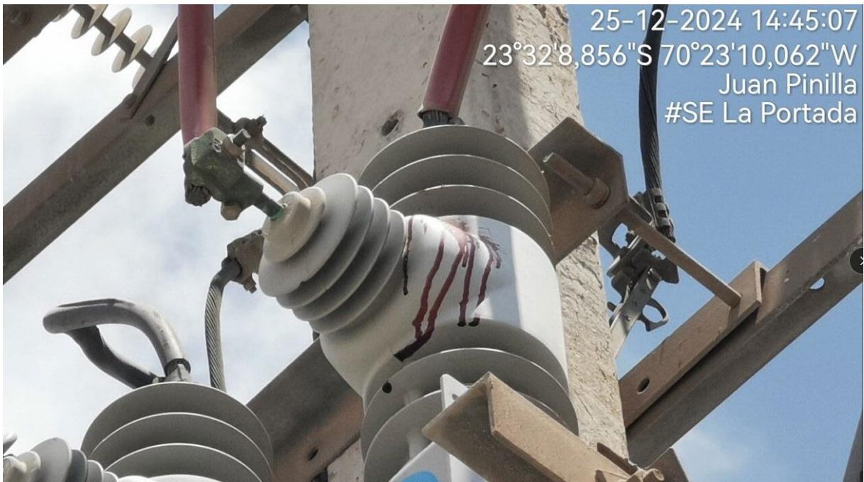
DETALLE EVIDENCIA CAIDA AVE ELECTROCUTADA DESDE ESTRUCTURA SUPERIOR DE EQUIPO 52ET3 UBICADA EN INTERIOR SE LA PORTADA .
