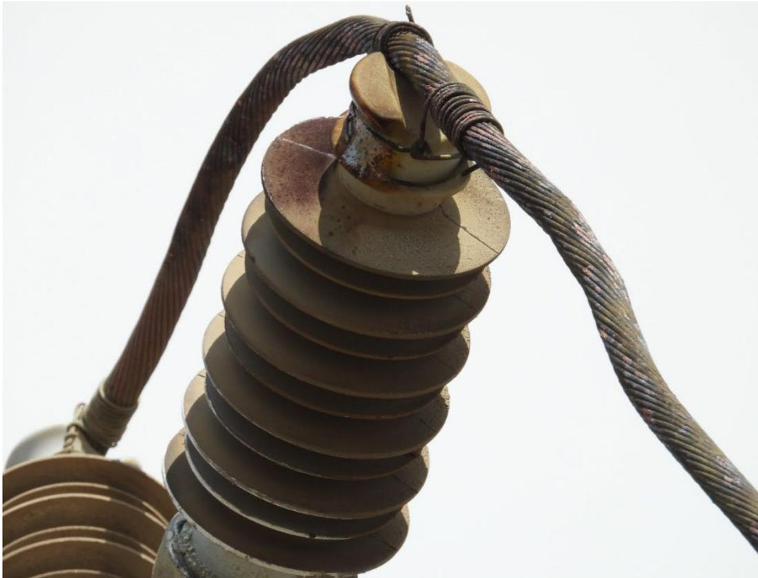
DETALLE AISLACIÓN ESTRUCTURA SUPERIOR LADO FUENTE 52ET3 UBICADA EN INTERIOR SE LA PORTADA AFECTADA POR DESCARGAS PRODUCIDAS POR AVE.
