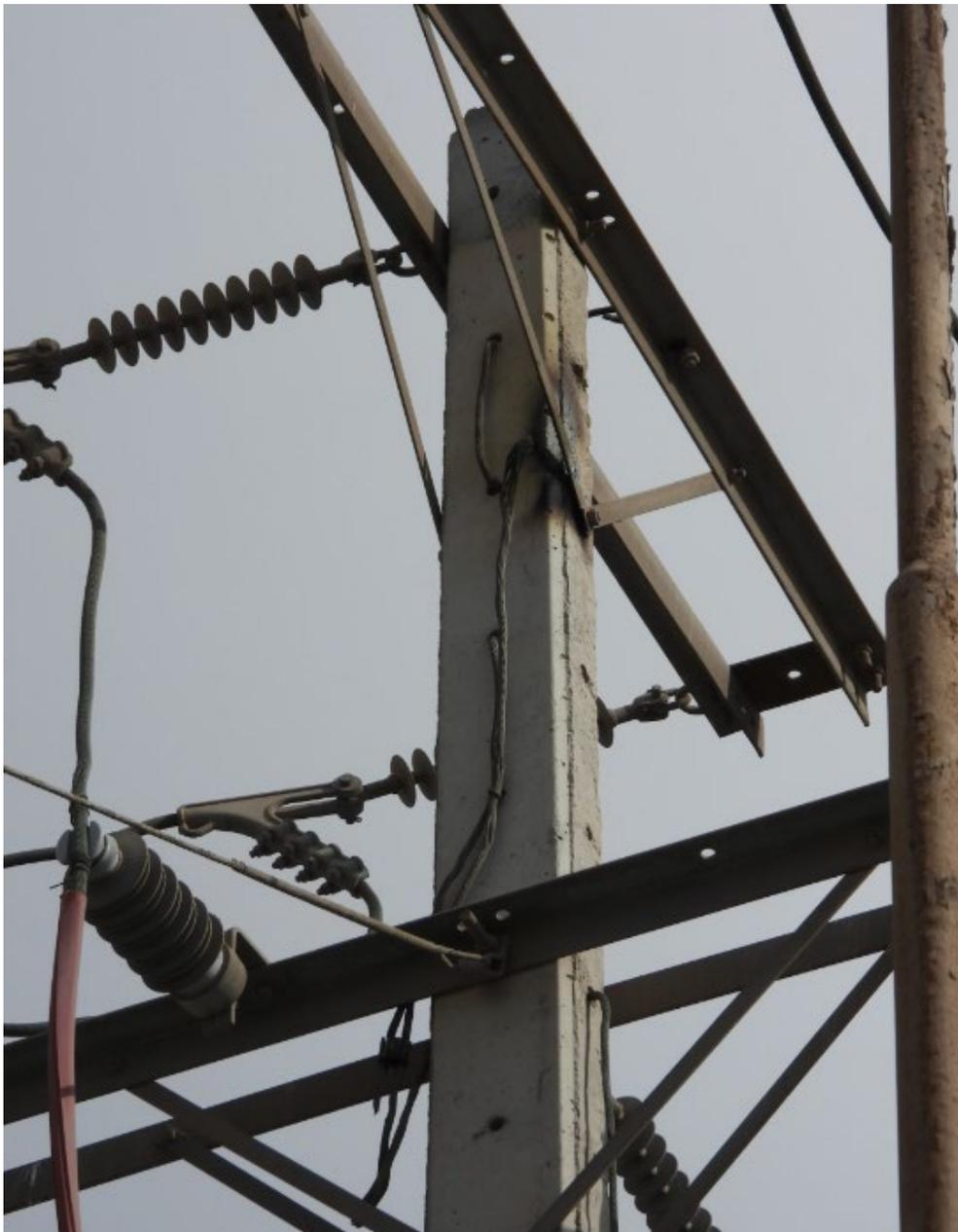
DAÑO EN TIERRA DE PROTECCIÓN ESTRUCTURA SUPERIOR 52ET3, PRODUCTO DESCARGAS POR AVE
