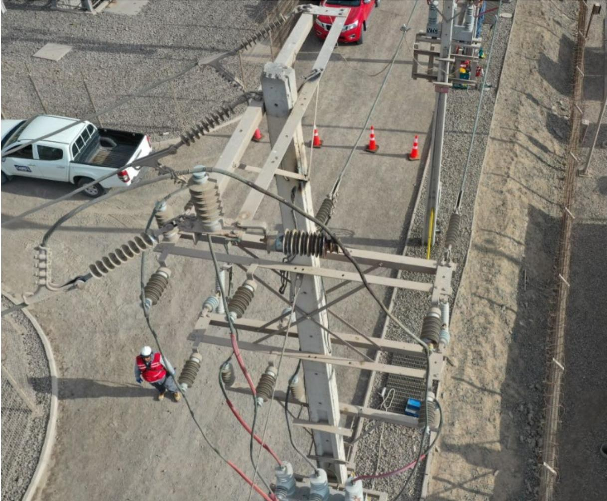
ESTRUCTURA SUPERIOR LADO FUENTE 52ET3 UBICADA EN INTERIOR SE LA PORTADA AFECTADA POR DESCARGAS PRODUCIDAS POR AVE .
