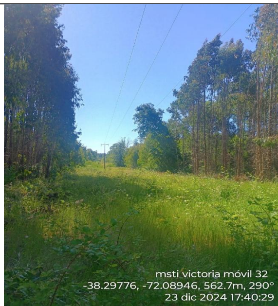
VISTA FINAL VANO 114 - 115
