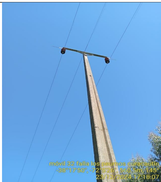
VISTA ESTRUCTURA N114
