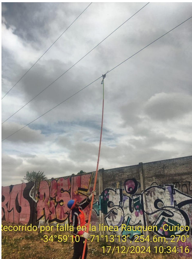
Figura 4 Trabajador quitando volantín de línea de transmisión.
