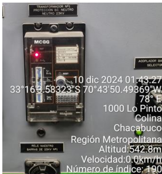
Protección de SC de neutro el TR1 operada
