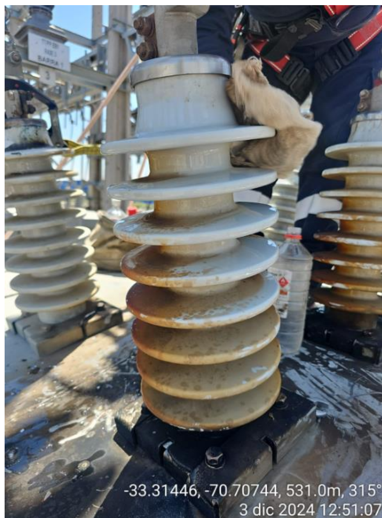
Figura 4: Limpieza aislación 52E1.
