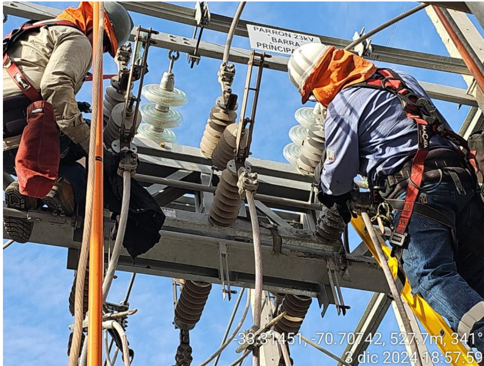
Figura 5: Limpieza aislación 89E1-2.
