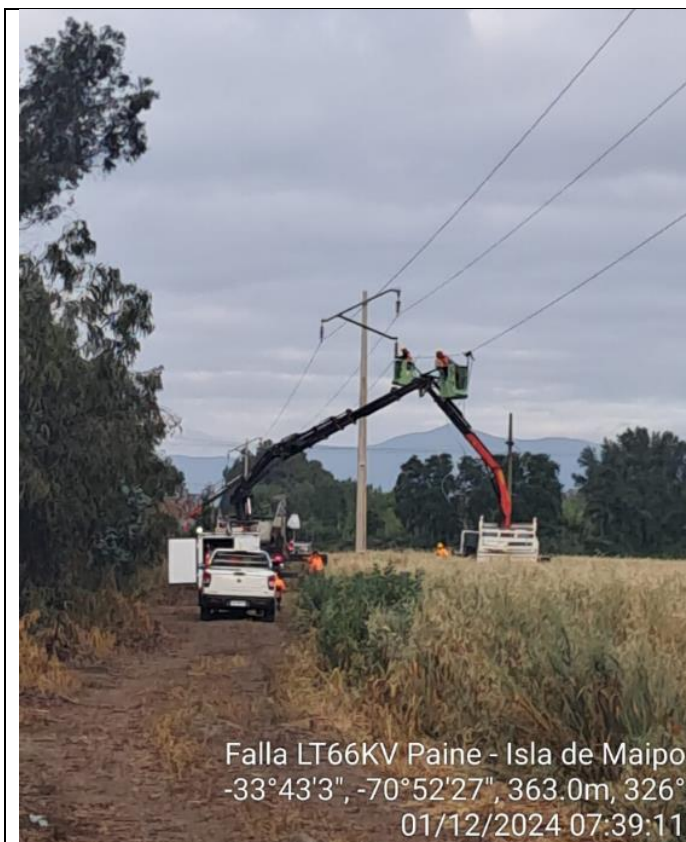
Figura 10.- La fotografía muestra los trabajos asociados a la reparación de la línea en el tramo de LT66kV Paine – Isla de Maipo.
