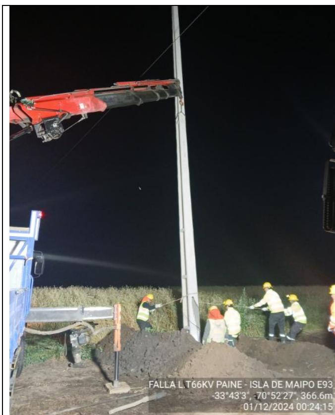
Figura 6.- La fotografía muestra los trabajos asociados a la reparación de la línea en el tramo de LT66kV Paine – Isla de Maipo.
