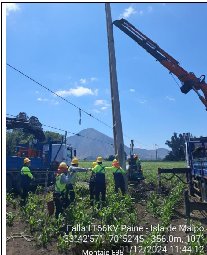
Figura 9.- La fotografía muestra los trabajos asociados a la reparación de la línea en el tramo de LT66kV Paine – Isla de Maipo.
