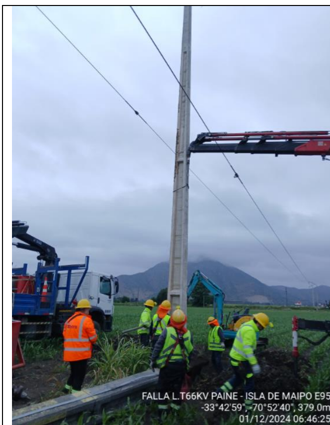
Figura 8.- La fotografía muestra los trabajos asociados a la reparación de la línea en el tramo de LT66kV Paine – Isla de Maipo.
