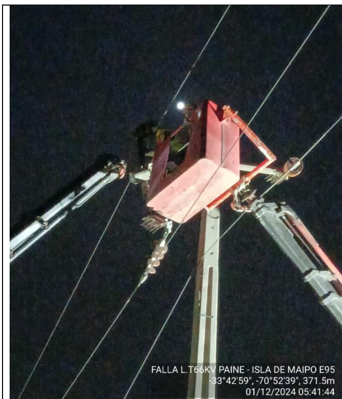
Figura 7.- La fotografía muestra los trabajos asociados a la reparación de la línea en el tramo de LT66kV Paine – Isla de Maipo.
