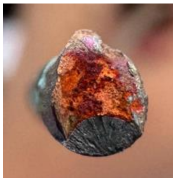
Imagen N°5: Hebra cortada por tracción el día de la falla y un corte por corrosión hace un tiempo no determinado.
