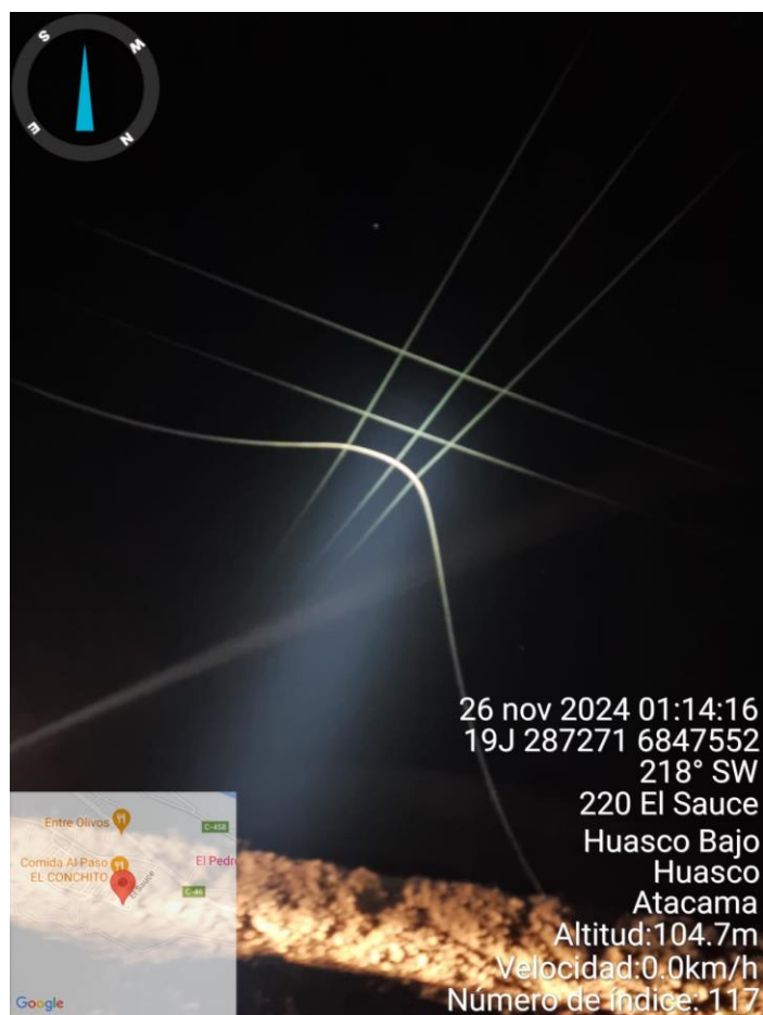
Imagen N°2: Línea de Transelec sobre línea de MT de CGE
