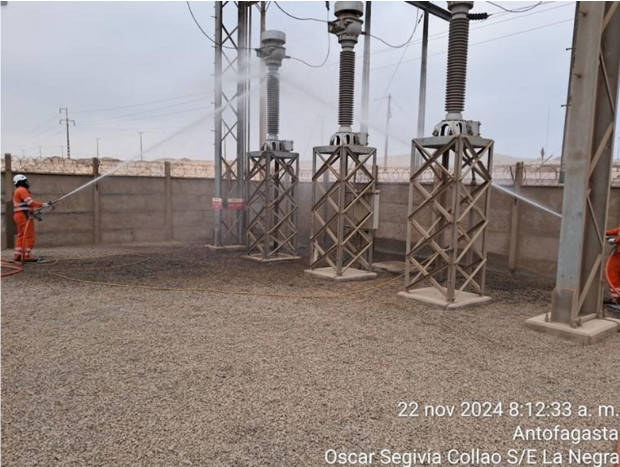
INICIO Y DESARROLLO TRABAJOS LAVADO AISLACIÓN SE TAP OFF LA NEGRA 22/11/2024.
