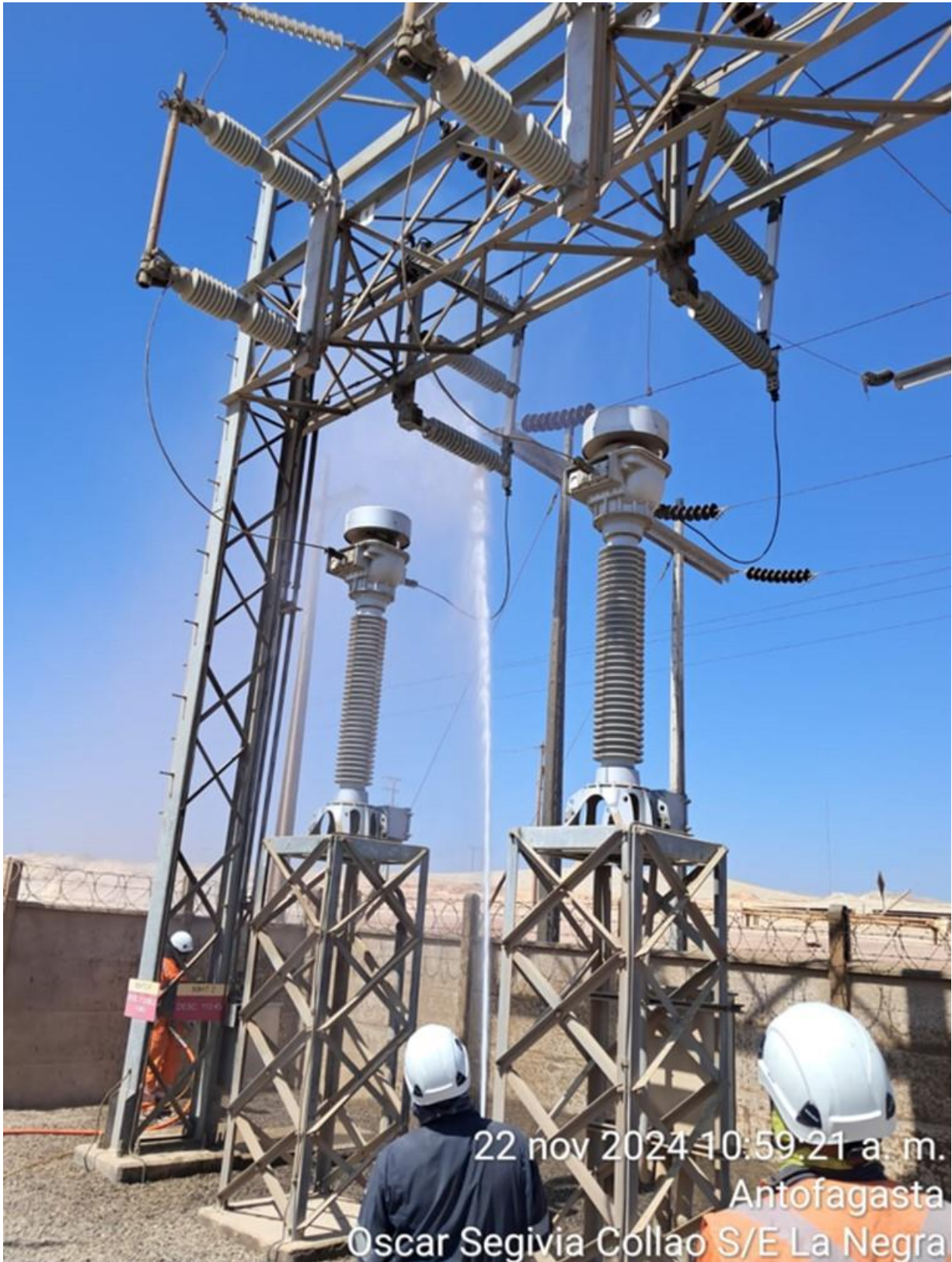
DESARROLLO TRABAJOS LAVADO AISLACIÓN SE TAP OFF LA NEGRA 22/11/2024.
