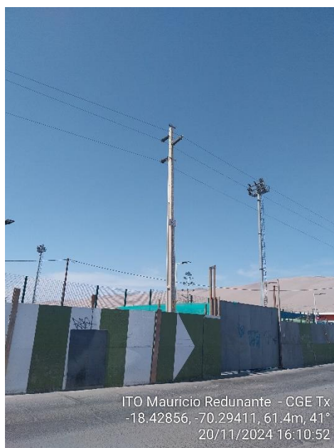
Panorámica de la Estructura
