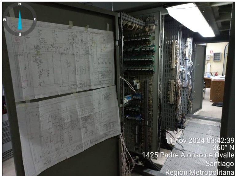
Figura N°6 – Levantamiento de alambrado de control.
