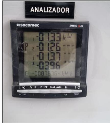
Figura 3.10 – Consumo SSAA esenciales Parque Fotovoltaico Conejo Solar – Hora 3
