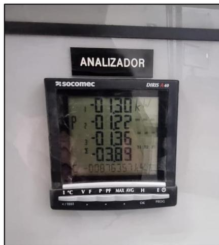
Figura 3.9 – Consumo SSAA esenciales Parque Fotovoltaico Conejo Solar – Hora 2
