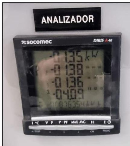
Figura 3.8 – Consumo SSAA esenciales Parque Fotovoltaico Conejo Solar – Hora 1
