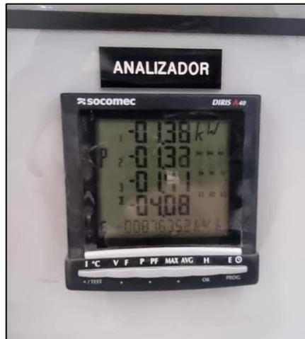
Figura 3.11 – Consumo SSAA esenciales Parque Fotovoltaico Conejo Solar – Hora 4
