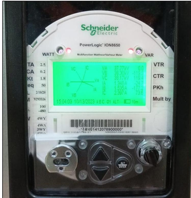
Figura 9.13 – Equipo medidor ION 8650 potencia neta
