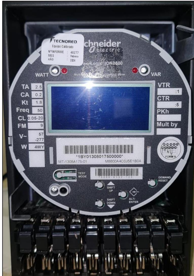
Figura 9.9 – Equipo medidor ION 8600 potencia bruta
