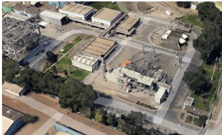
Figura 4.1 Ubicación Central Termoelectrica Newen.
