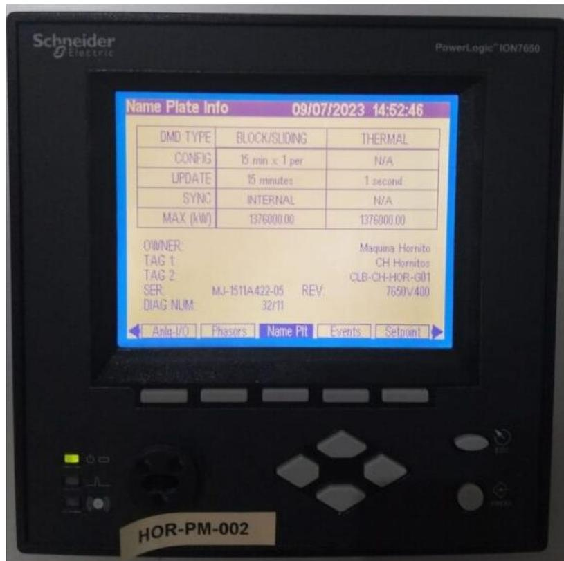
Figura 9.5 - Equipo medidor ION 7650 potencia bruta U1
