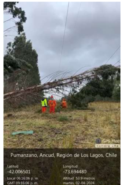
Fotografías N°3: Probatorio de árboles caídos sobre la línea. STN – STS – SAGESA – SGA – CAITÁN - TOLCHÉN – LT CABO LEONES – SATT 5
