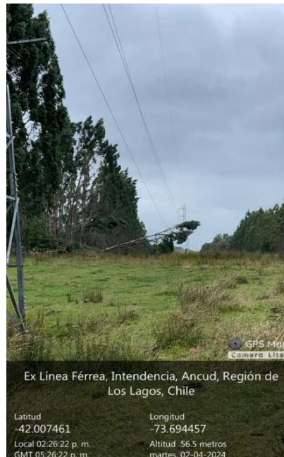
Fotografías N°3: Probatorio de árboles caídos sobre la línea. STN – STS – SAGESA – SGA – CAITÁN - TOLCHÉN – LT CABO LEONES – SATT 5
