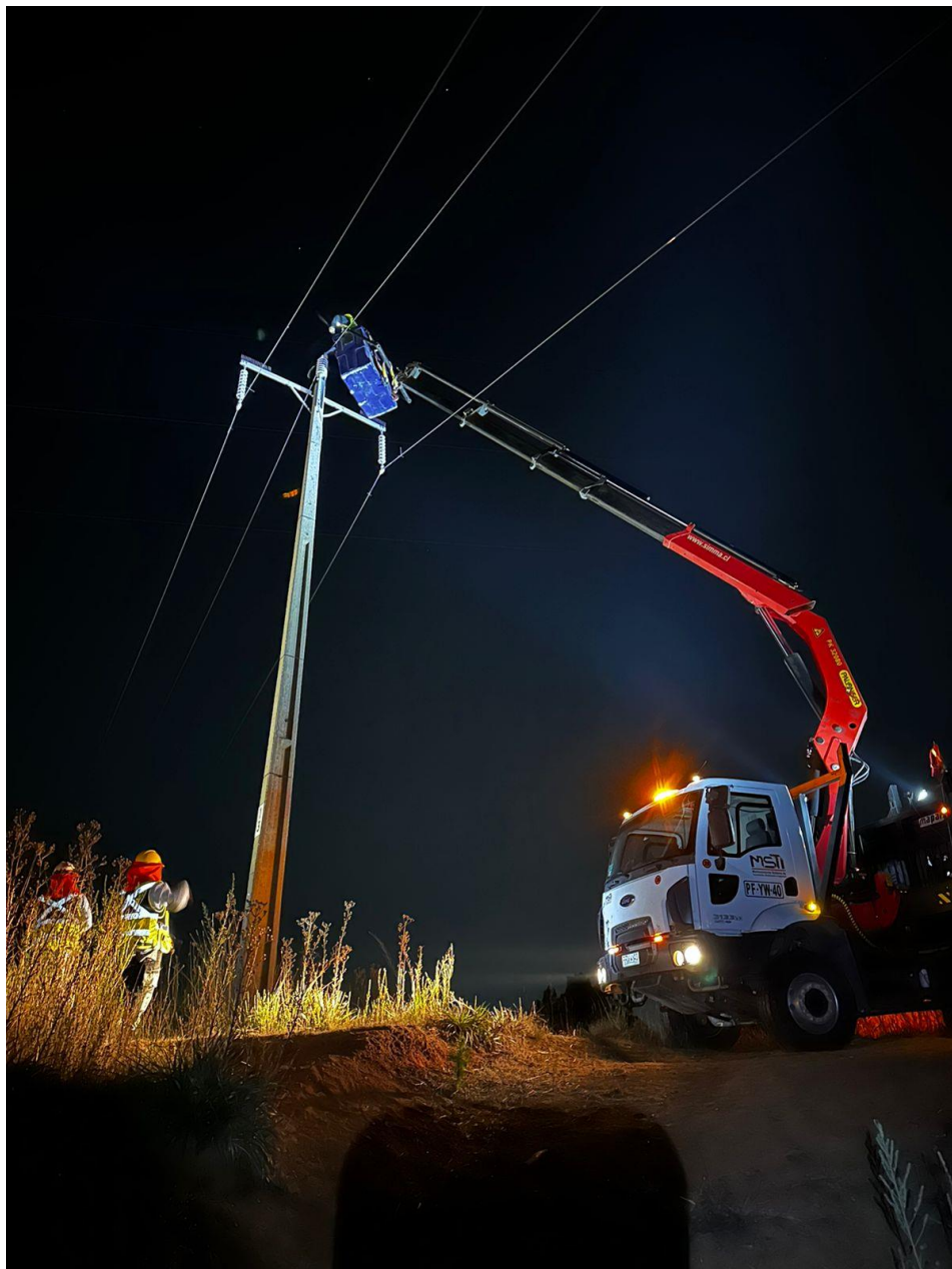
Fotografía N° 4: Reparación de conductor de línea Alonso de Ribera-Chiguayante.
